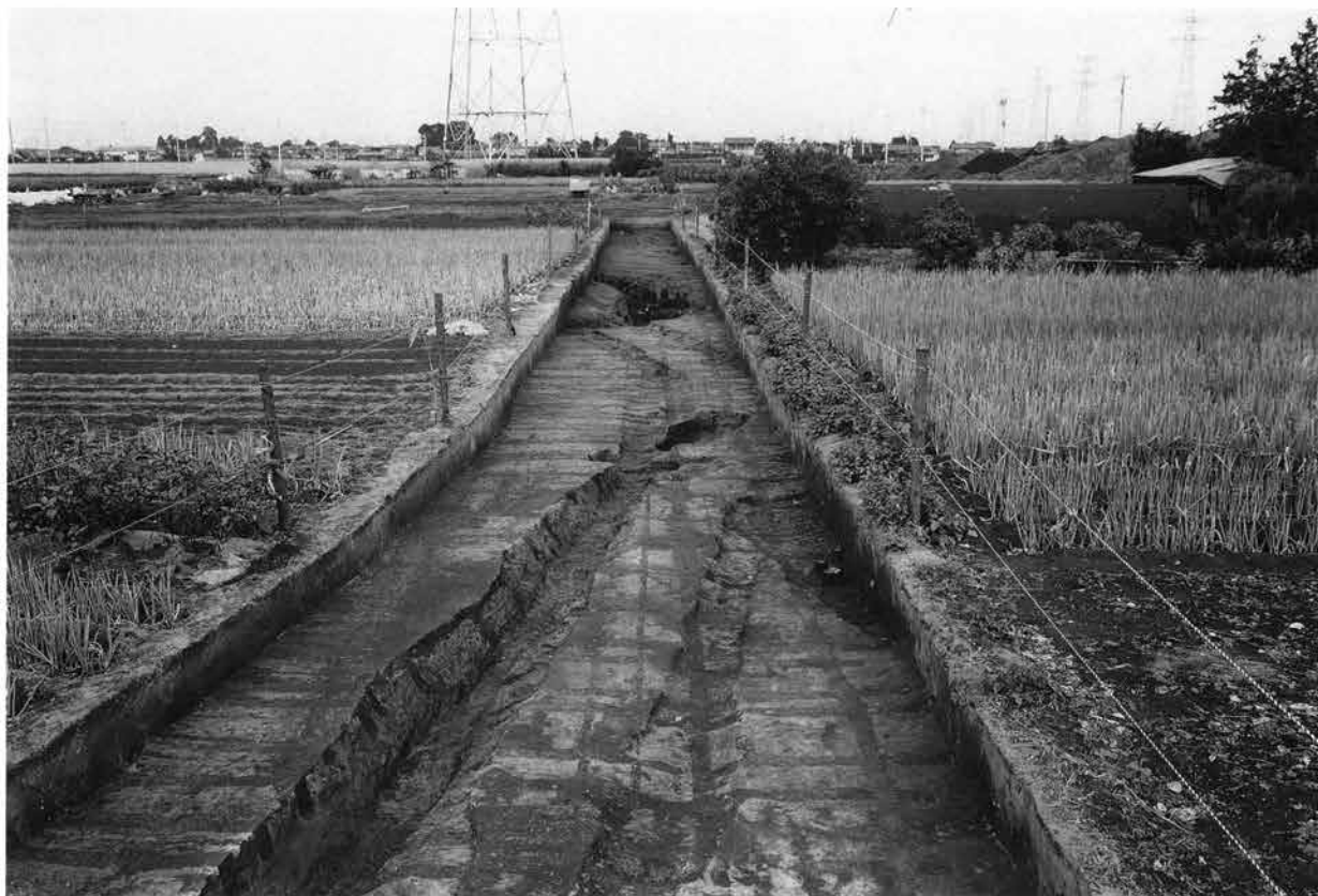
1. 1号道路遺構 (南から)
