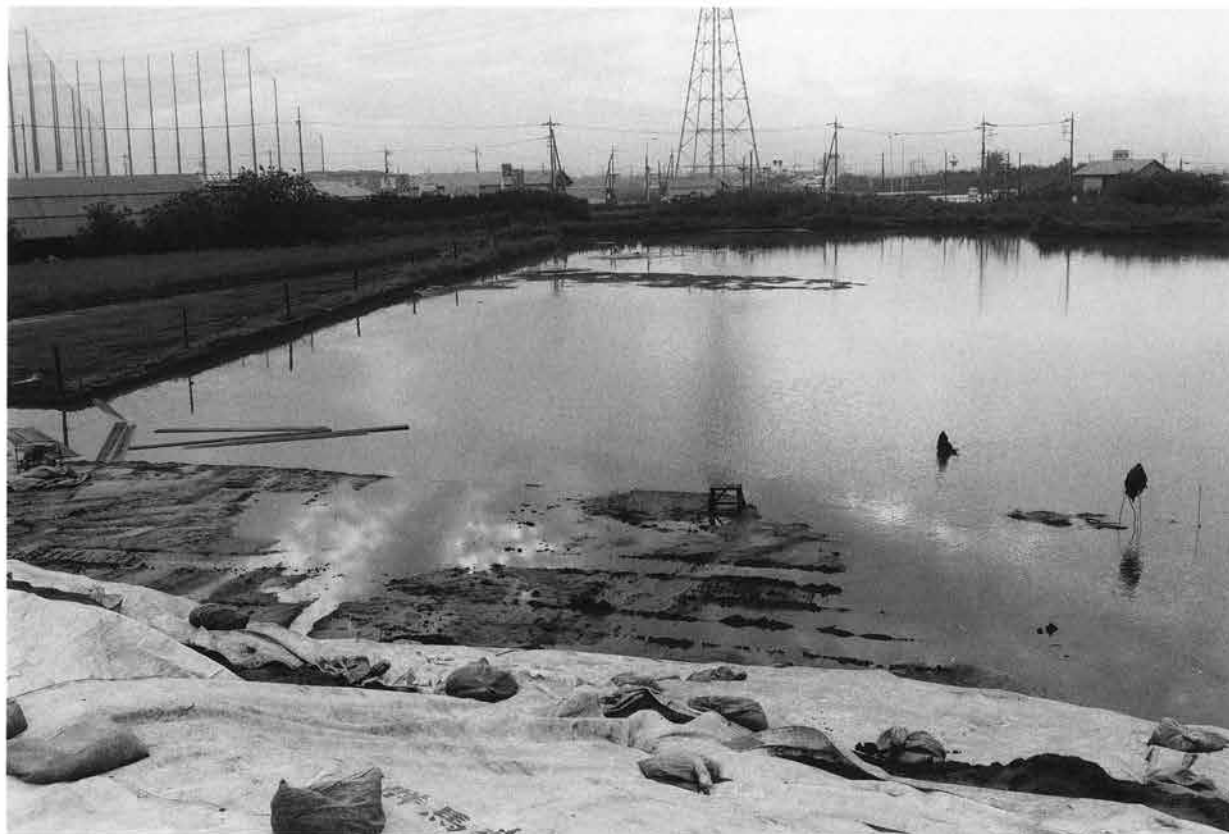
1. 冠水した調査区（調査中、台風により3回調査区が冠水した。本線部分、東から）
