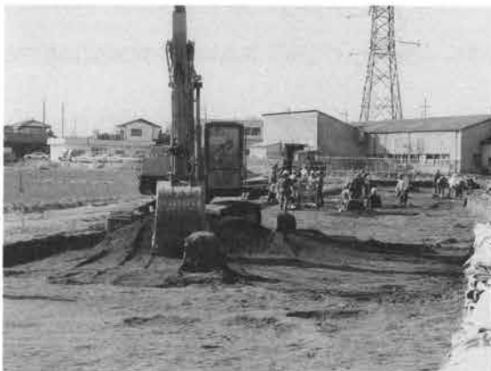
バックホーによる表土掘削（西区：東から）
