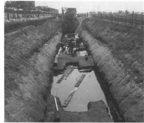
2 本調査I段階(北西から)
