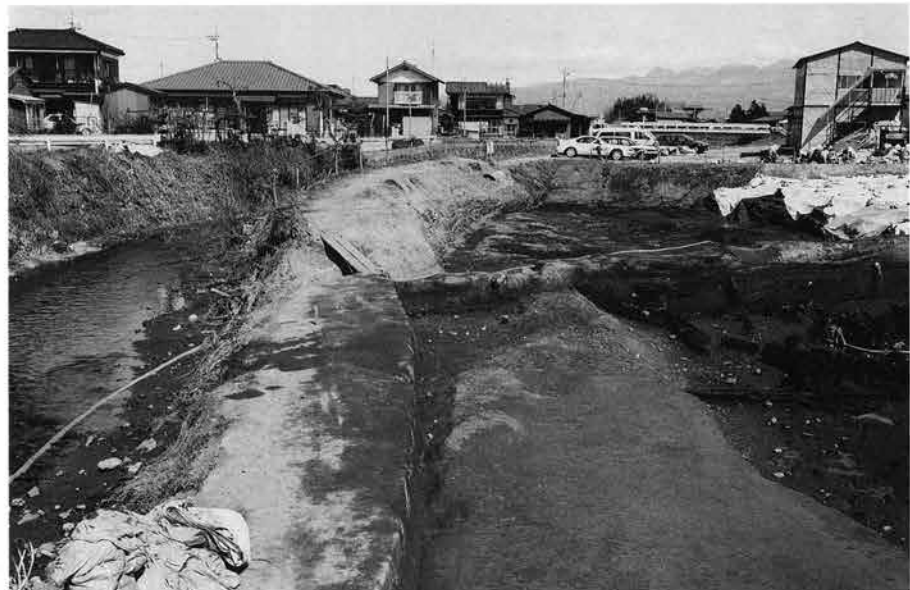
3 E区I面3号河川跡 (南より)
