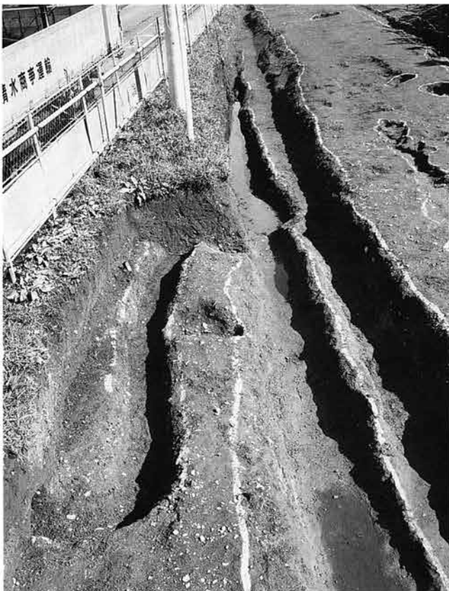
3. 北東区中央部完掘状況 (3・32・33号溝) (南より)
