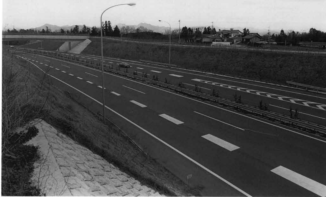
1 白倉下原遺跡 (南東から)
