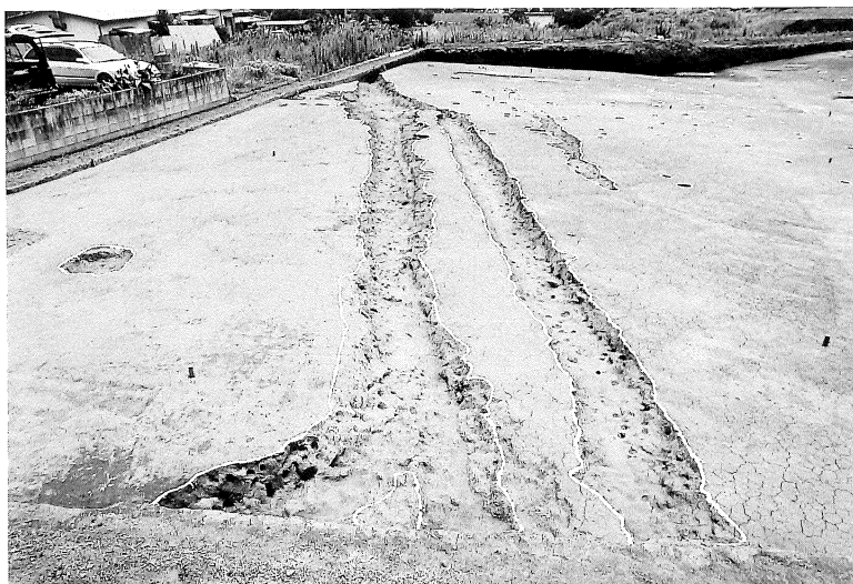
8号溝 a・b完掘状況
