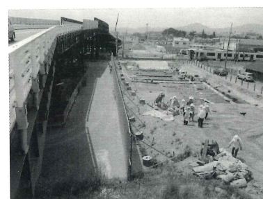
52次調査風景（北から）
