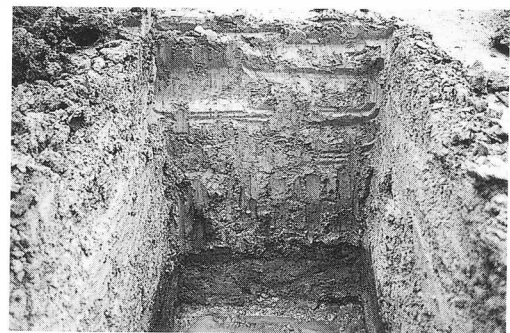
第86図 トレンチ掘削状況
