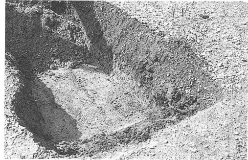
第64図 トレンチ掘削状況
