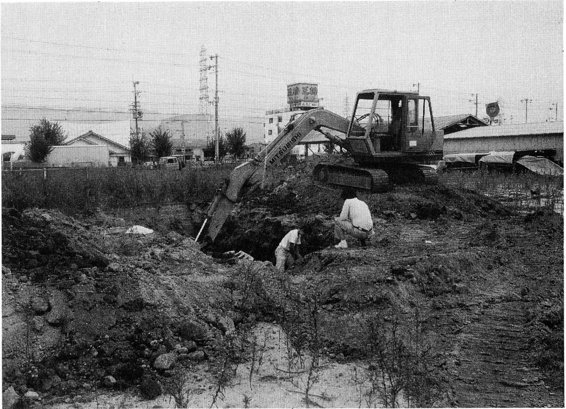
掘削状況（北西から）
