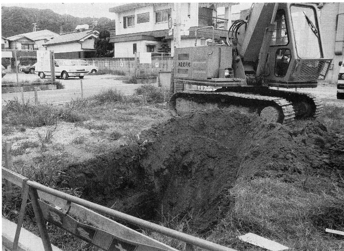
掘削状況（北西から）
