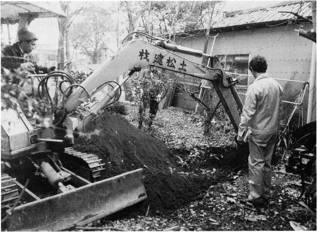
西トレンチ掘削状況（北西から）
