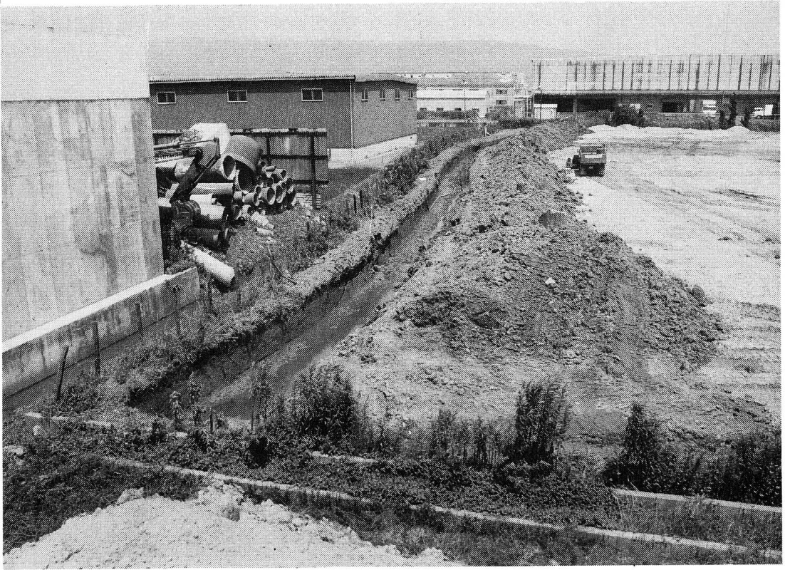
第1トレンチ全景（西から）
