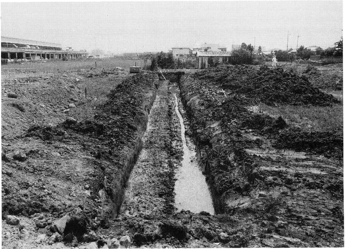
第3トレンチ全景（西から）
