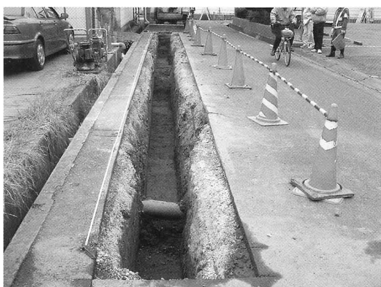
4T 全景 (北東から)
