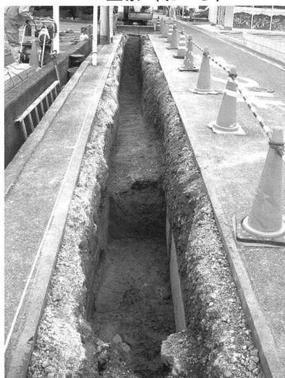
2T 全景 (北東から)
