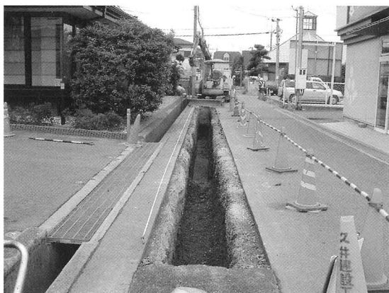
3T 全景 (北東から)
