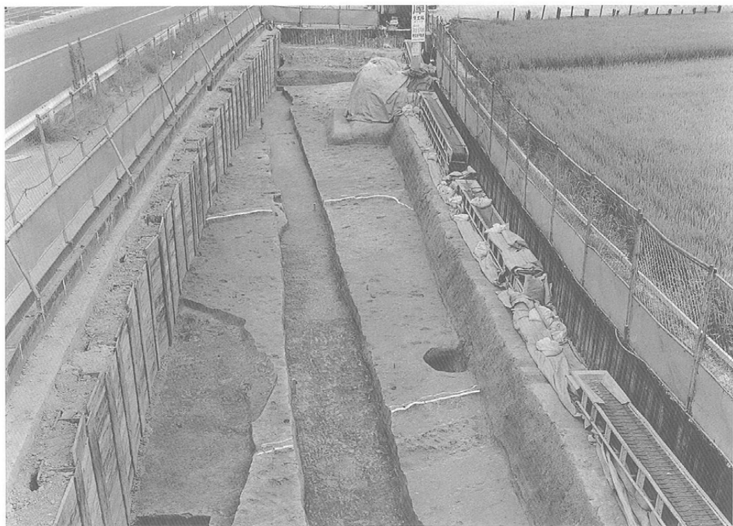
Ⅱ区 長原4Biii層上面の遺構 (西から)
