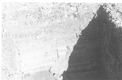
第138図 トレンチ掘削状況
