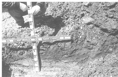
第112図 トレンチ掘削状況
