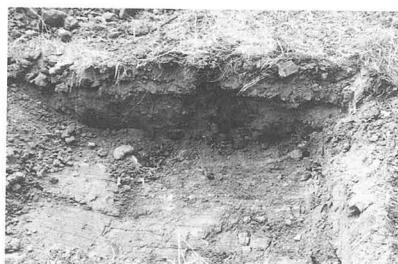
第136図 トレンチ掘削状況
