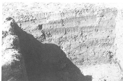
第142図 トレンチ掘削状況
