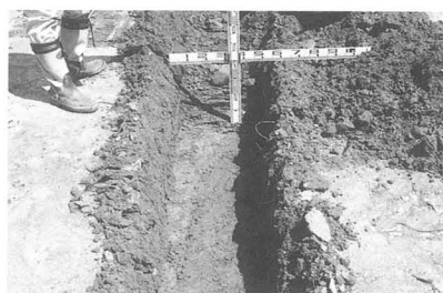
第114図 トレンチ掘削状況
