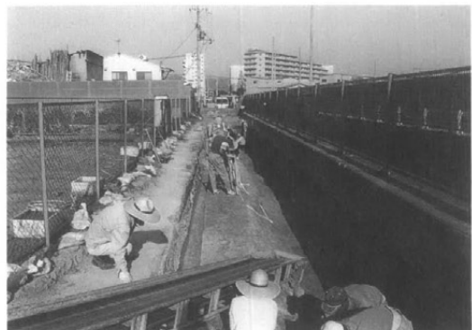
写真5 93-5次調査風景(西から)
