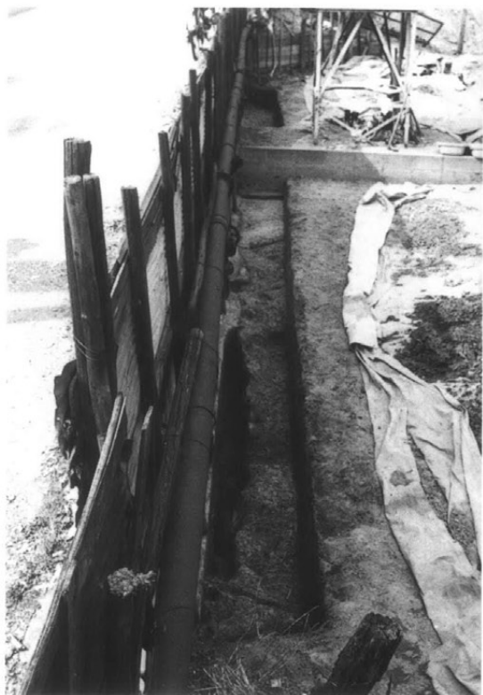
南区 全景(南から)
