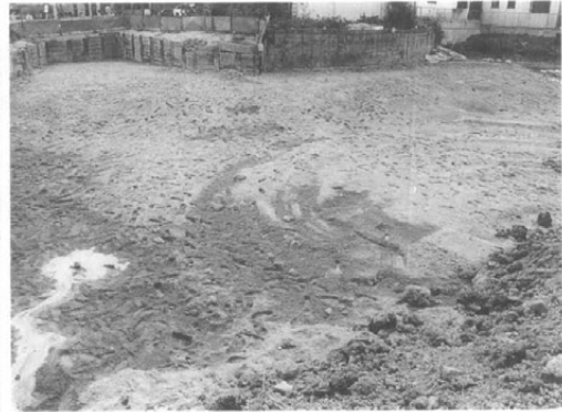
写真3 一ヶ塚古墳の保護砂による埋戻し
