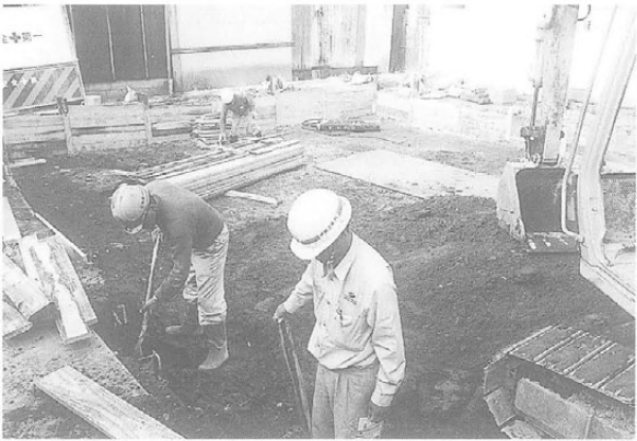
人力による土層掘削
