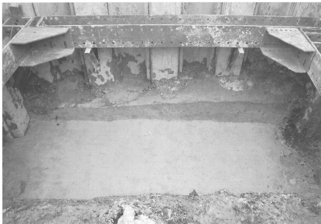
PSD19掘削状況（南から）
