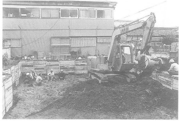
ショベルカーによる表土除去作業
