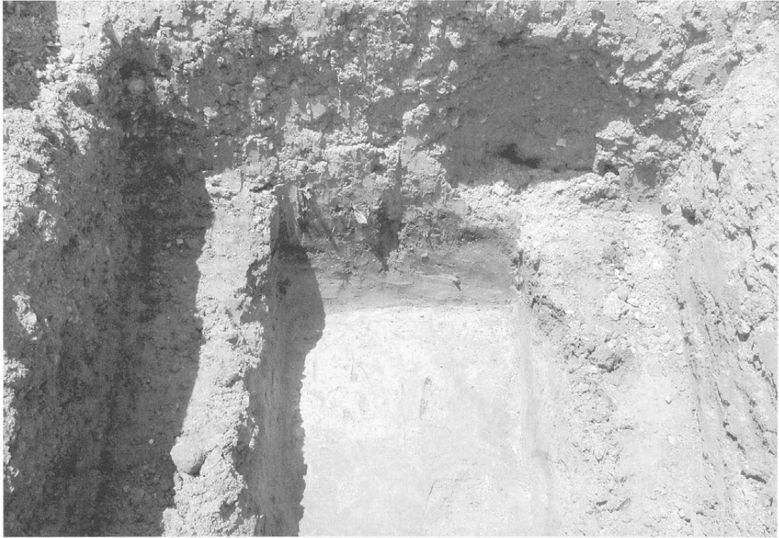
人孔C掘削状況（東から）
