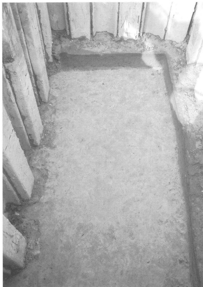
PSD17掘削状況（南から）
