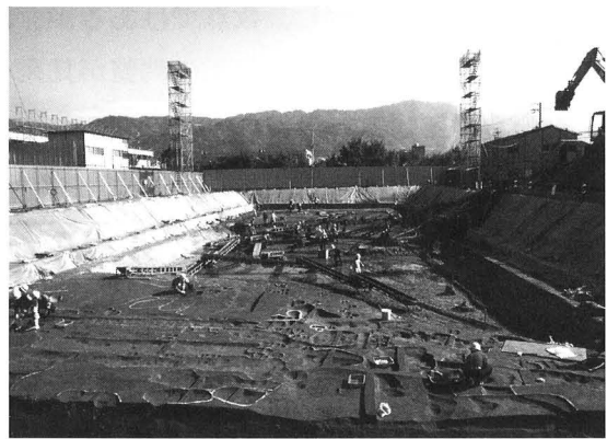
写真20 第6面西部調査状況(西から)
