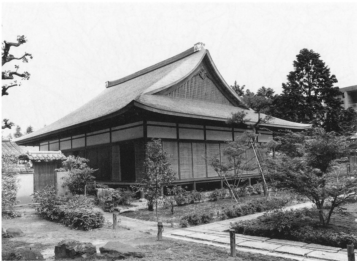
a. 建造物保存修理 (普門寺)
