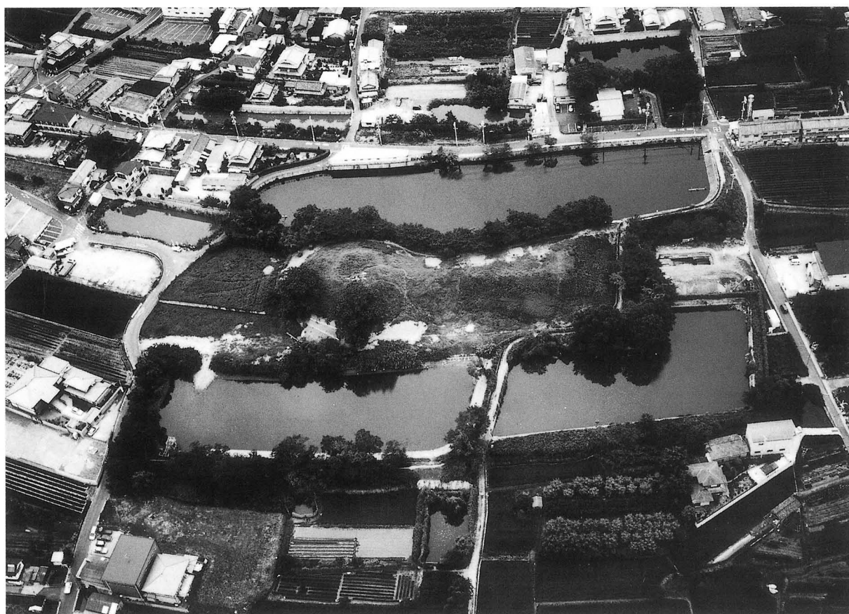
古墳全景(西上空から)
