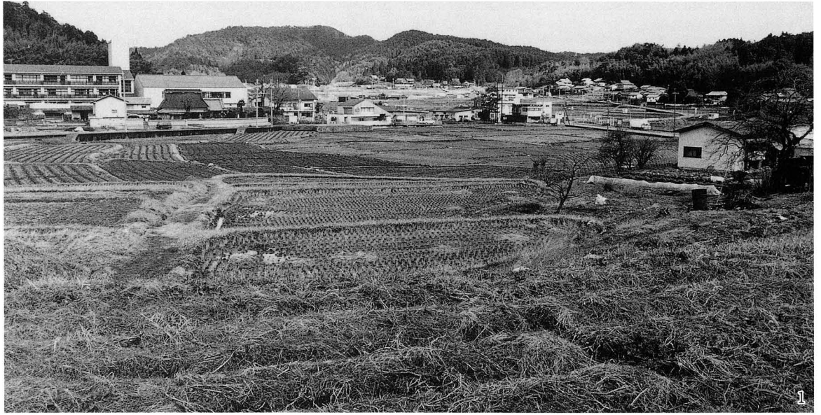
1. 田能地区全景 南より
