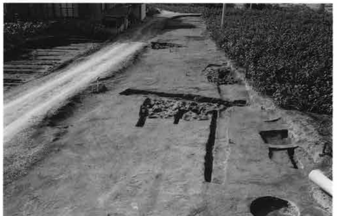
8. II区取り付け道路部 (東から)
