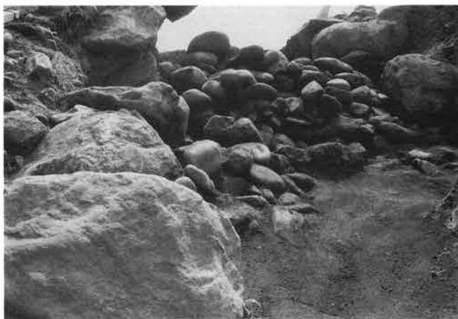
3. 羨道部閉塞石残存状態 (西より)
