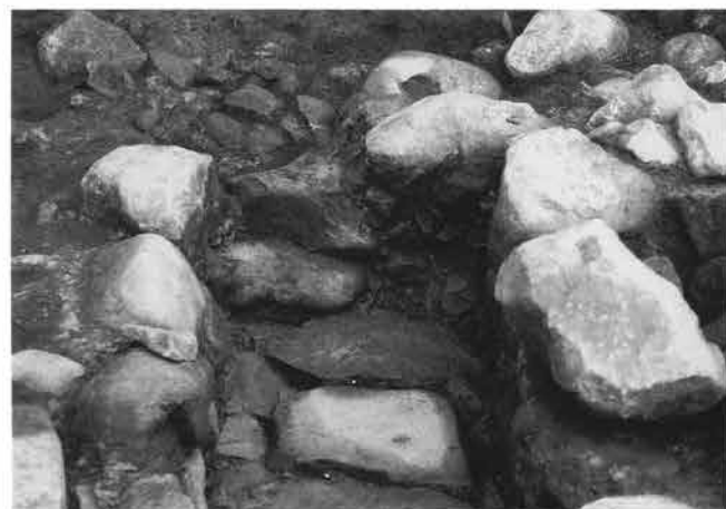
4. 西壁構築状態
