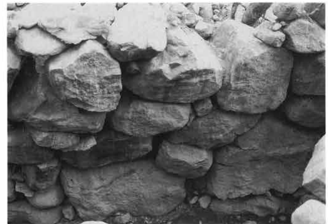
8. 右壁構築状態
