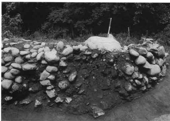
2. 石室奥壁部裏込め被覆(北東より)
