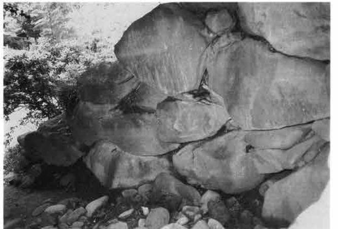
6. 石室左壁構築状態 (玄室より)
