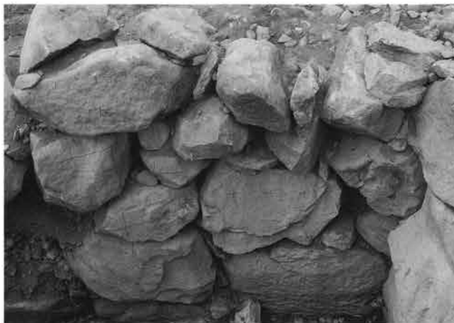
7. 左壁構築状態
