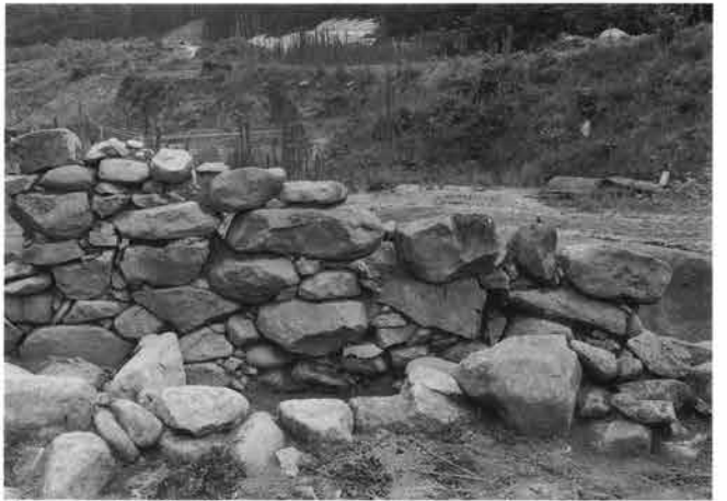
6. 玄室右壁構築状態
