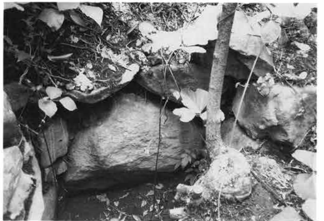
4. E号墳玄室右壁構築状態
