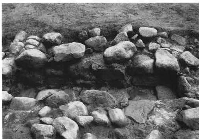
2. 南壁構築状態
