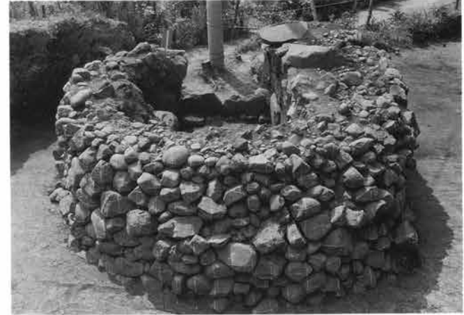
6. 石室裏込め被覆全景 (東より)
