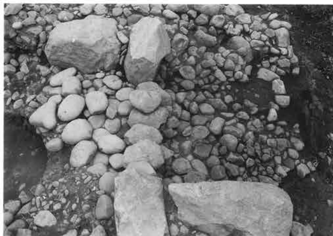
1. 石室右壁構築状態 (南東より)
