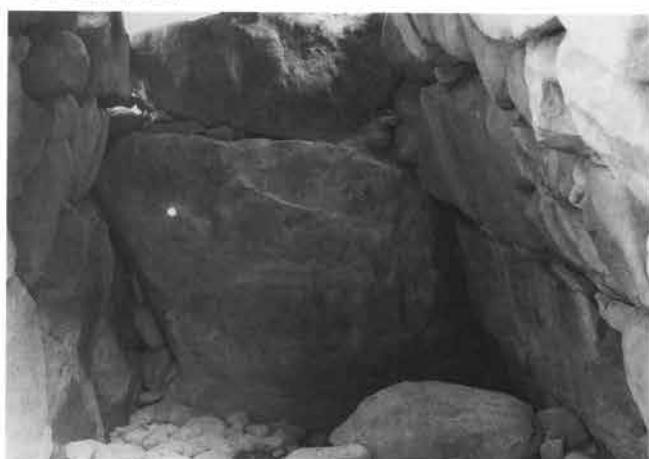
7. 石室奥壁構築状態
