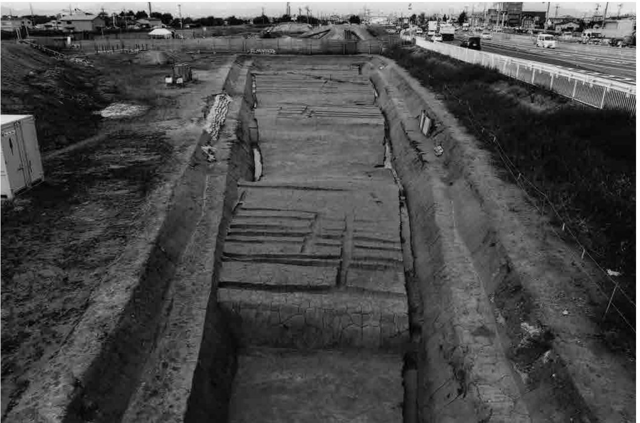
(2) K 2 区全景 (南から)
