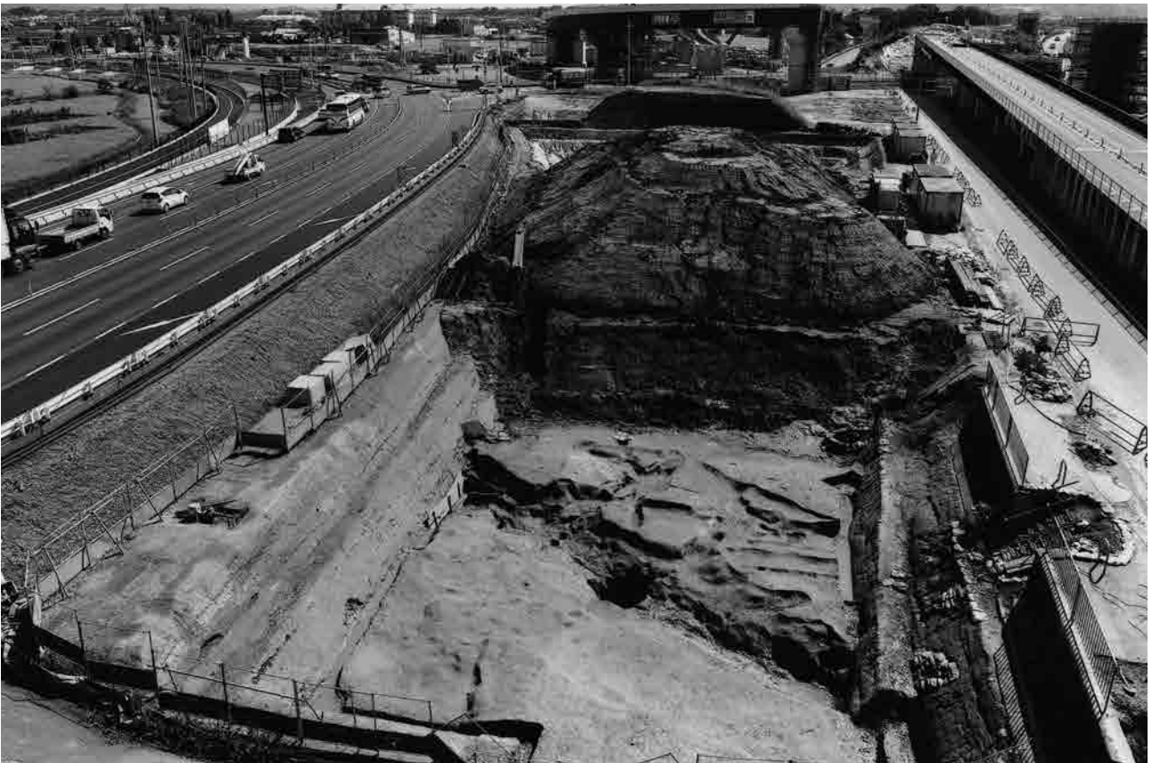
(2) H 地区溝 S D25 全景 (北から)
