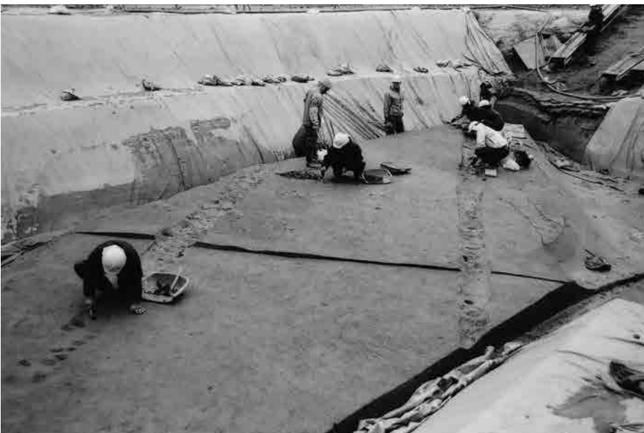
(3) E 9 区作業風景(南から)
