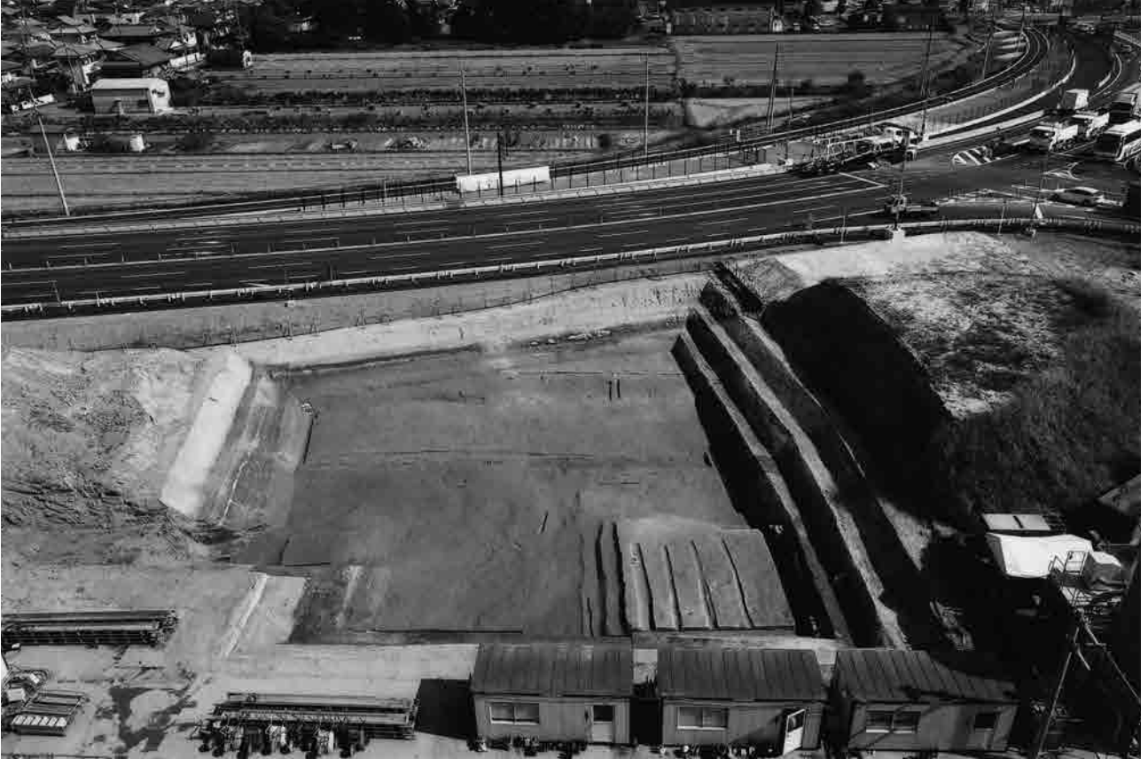
(1) H地区南半部全景(西から)
