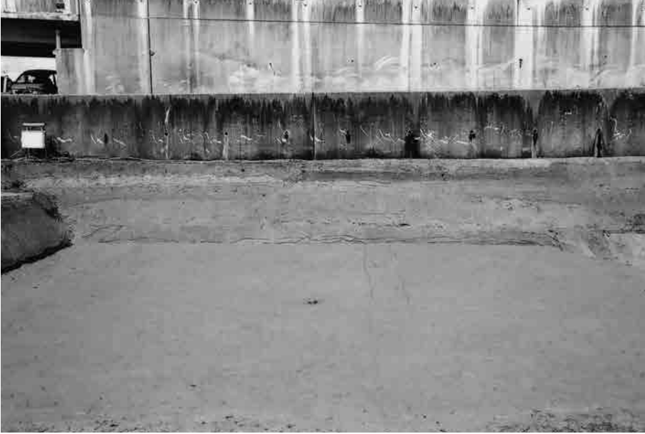
(1) H地区島畑99土層断面(東から)
