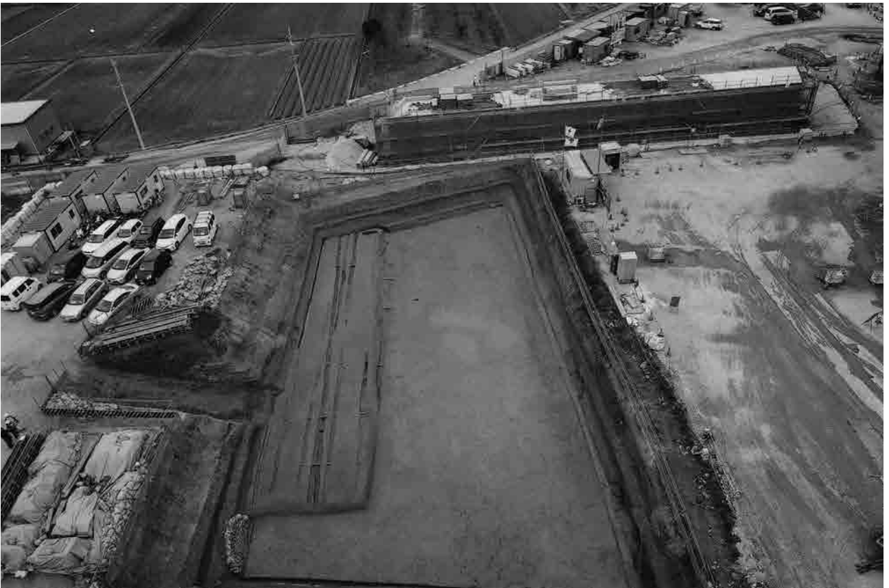
(2) D 地区上層遺構全景(北から)
