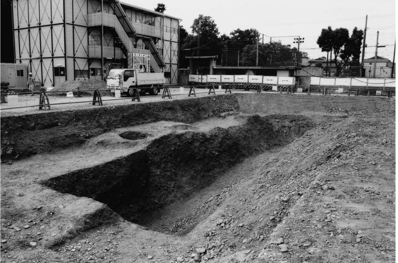
(1)北地区北西部(6トレンチ)断ち割り状況(南東から)
