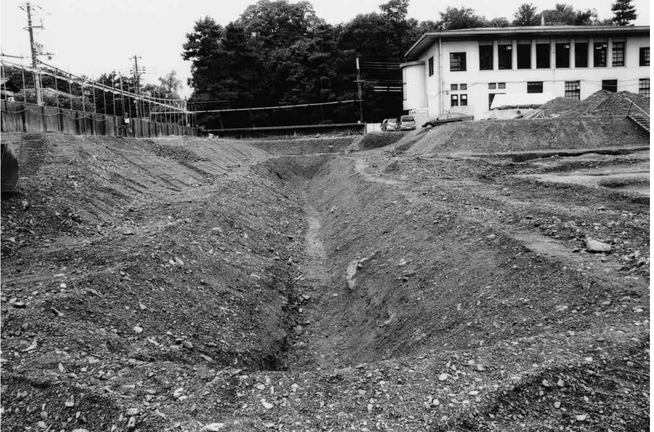
(1)南地区(4・7トレンチ)断ち割り状況(東から)
