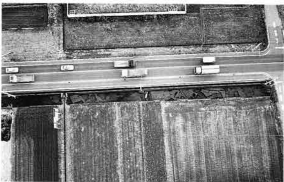
6. 2区西半部 (上空より)
