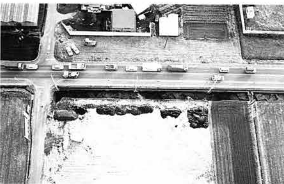
5. 2区東半部 (上空より)
