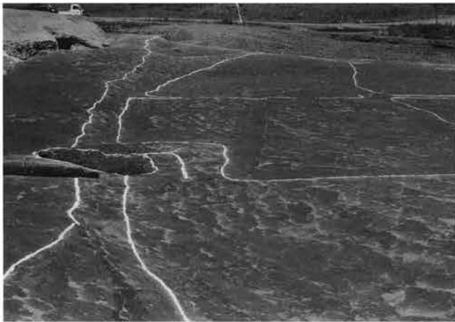
2 同1 縁辺部の段差
