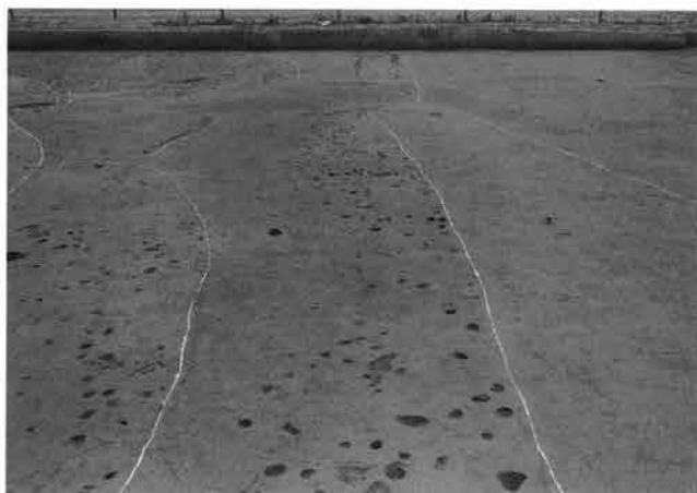
2 同 段差のないアゼの確認状況
