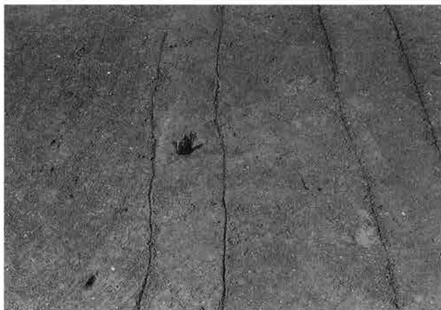
1 4区Ⅲ期畠 確認状況
