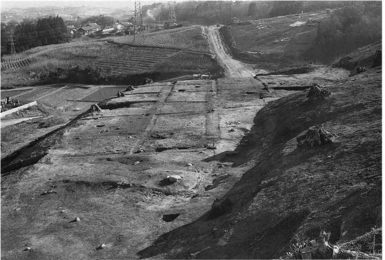
1号テラス全景 (西から)
