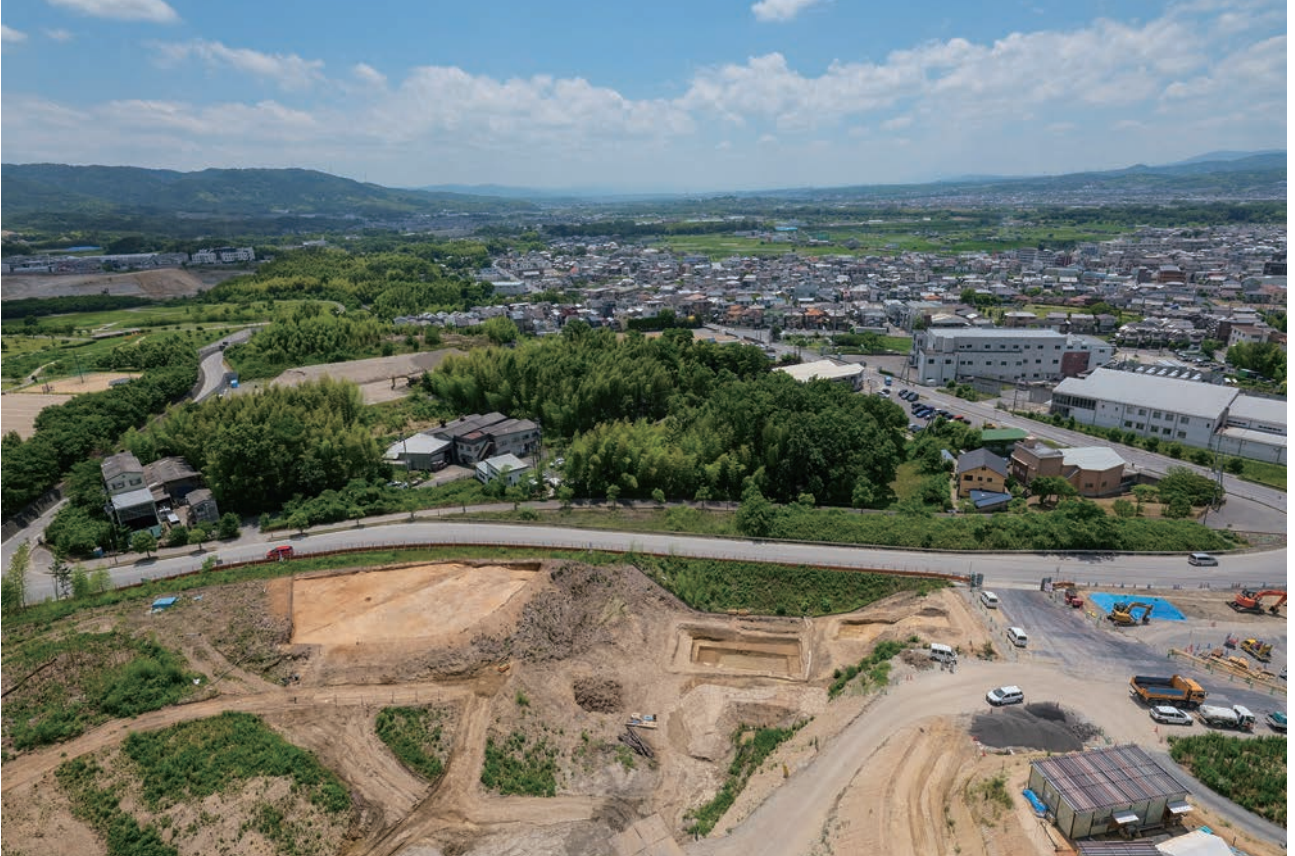
(1) V-1 地区遠景(北から)
