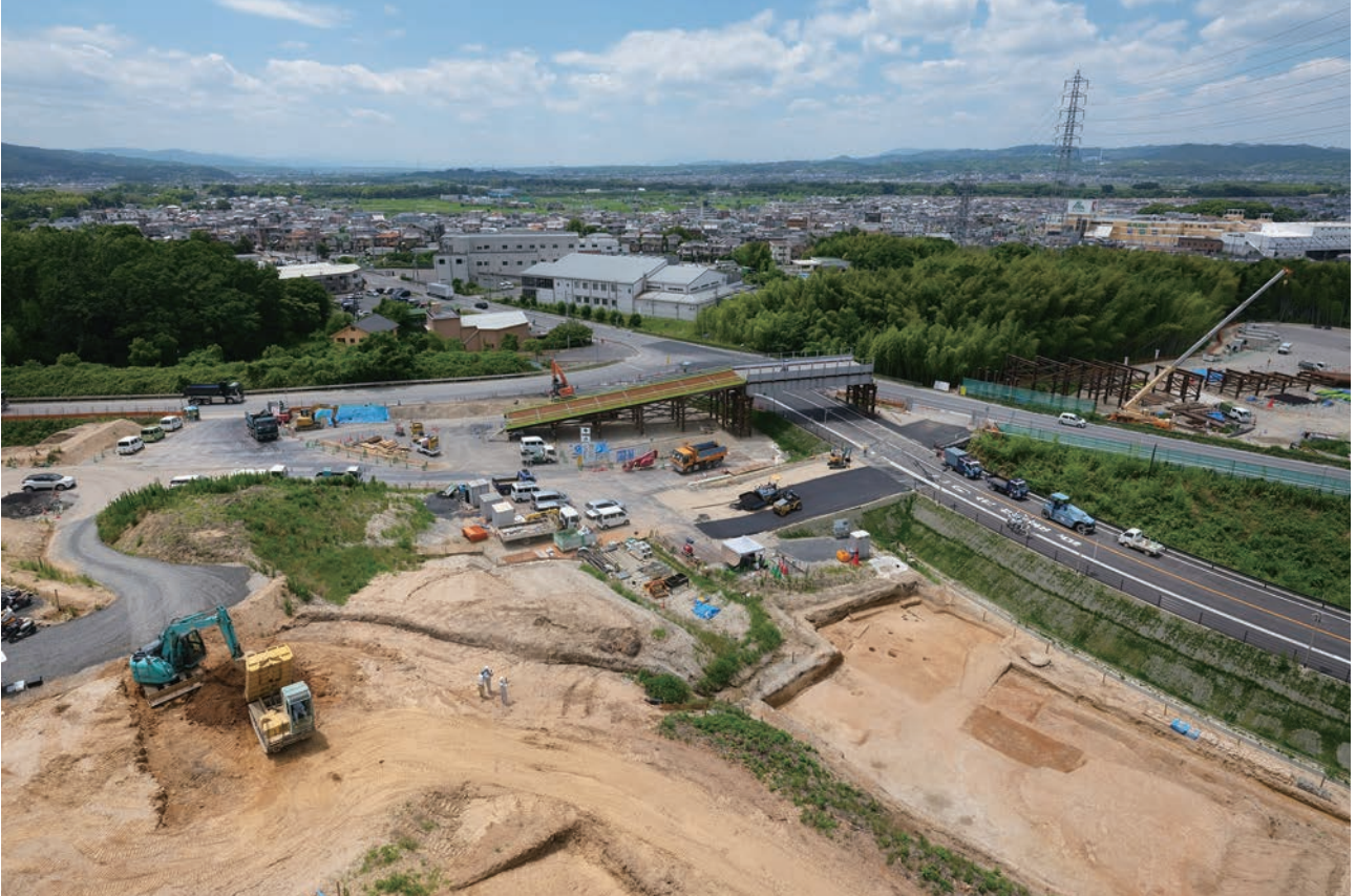
(1) R-3地区遠景(北から)
