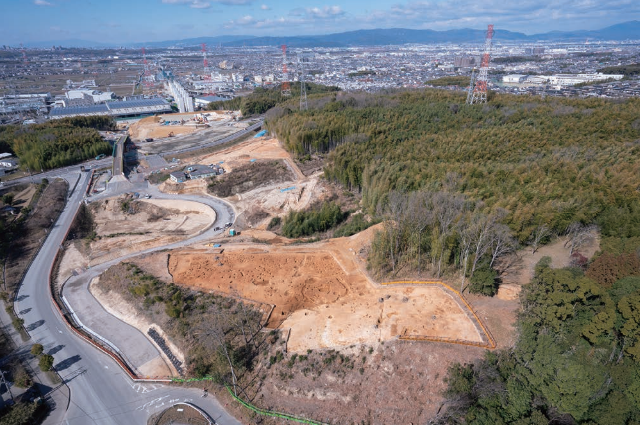
(1) V-5地区遠景(東から)
