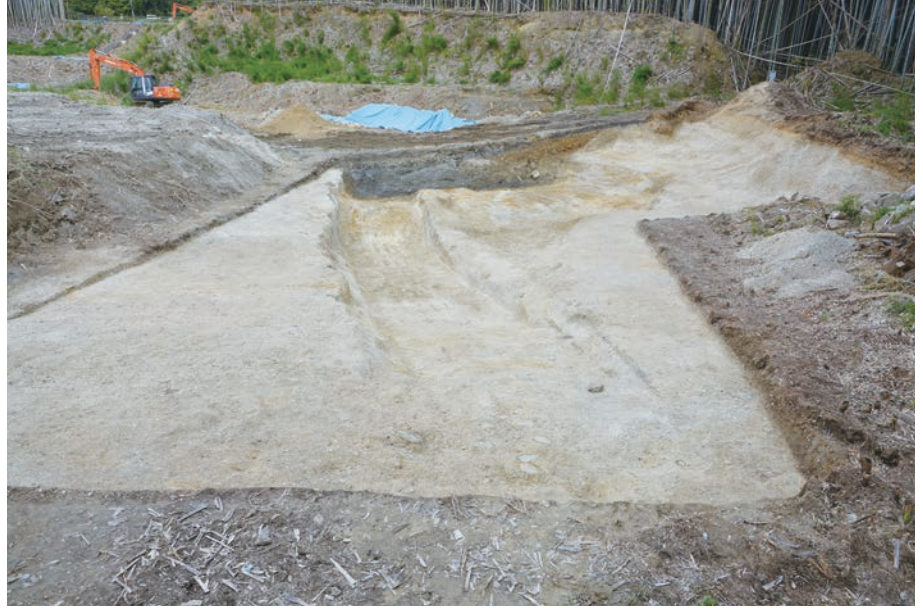
(1) C 地区 5 トレンチ 全景 (西から)
