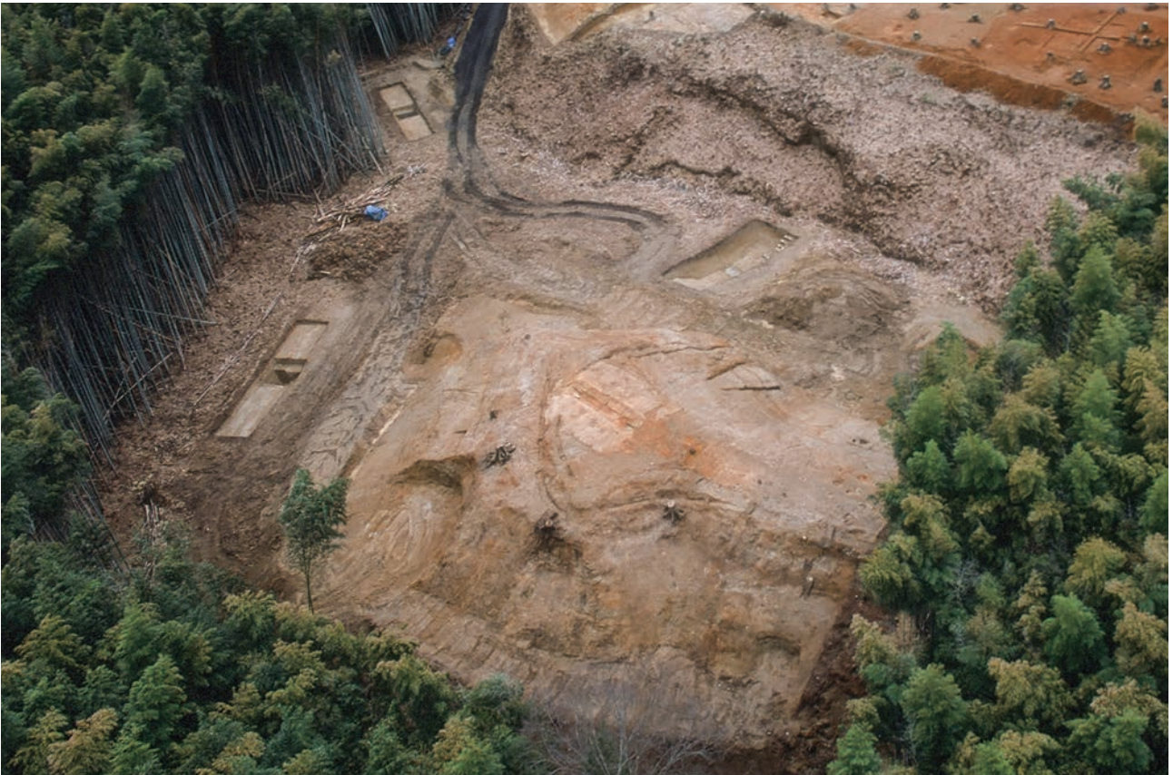
(2)E地区調査地近景(北東から)
