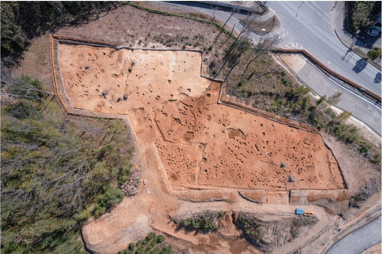
(2) V-5地区全景(上が東)
