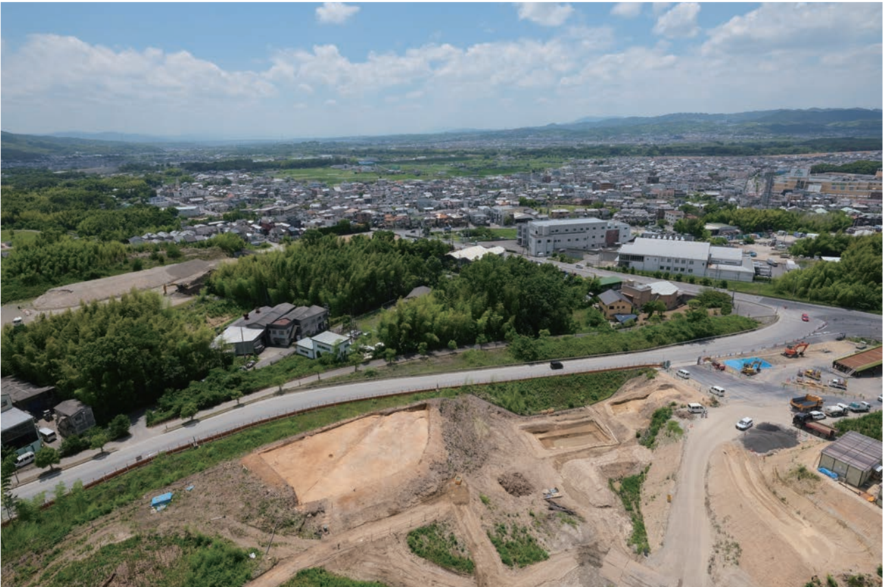
(2) V-1 地区遠景(北東から)
