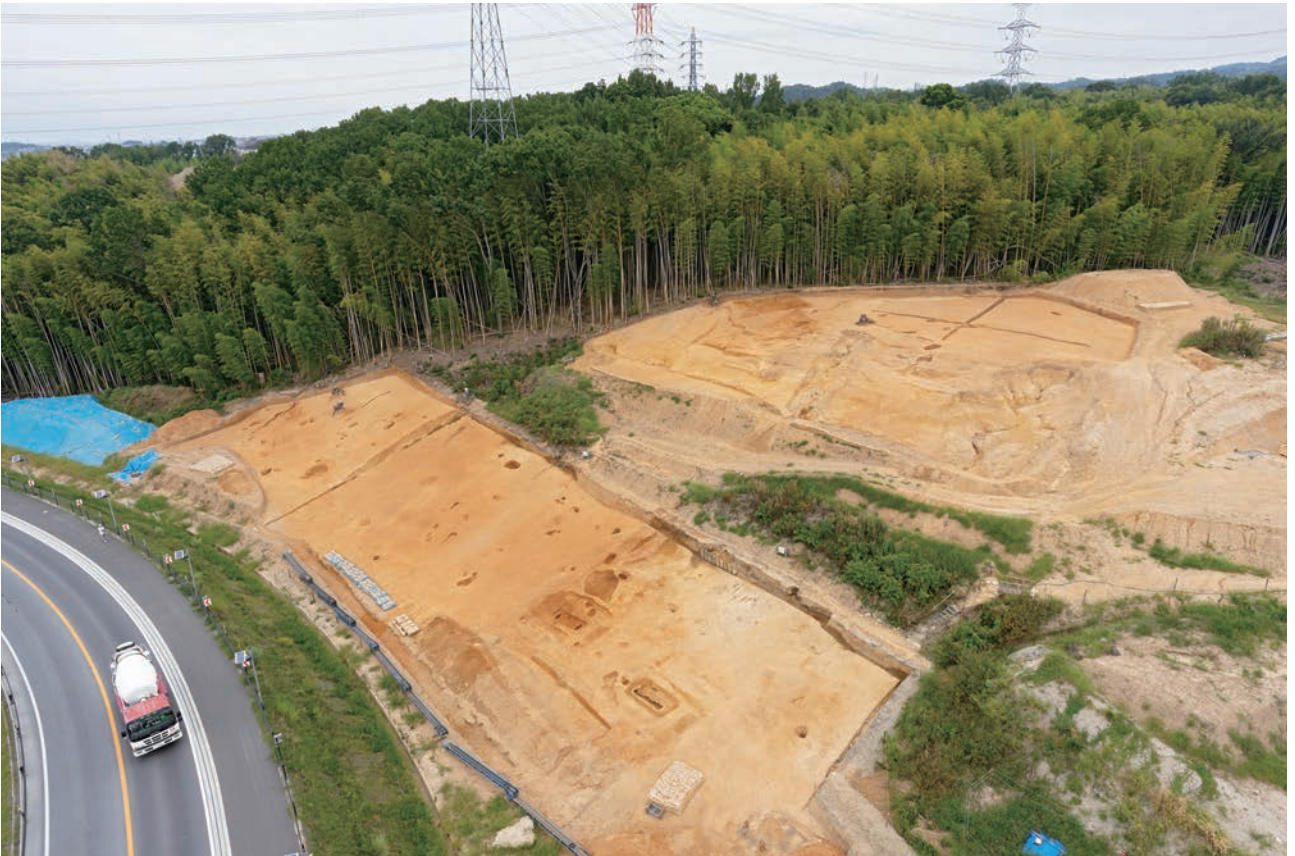
(2) R-4地区全景(北西から)
