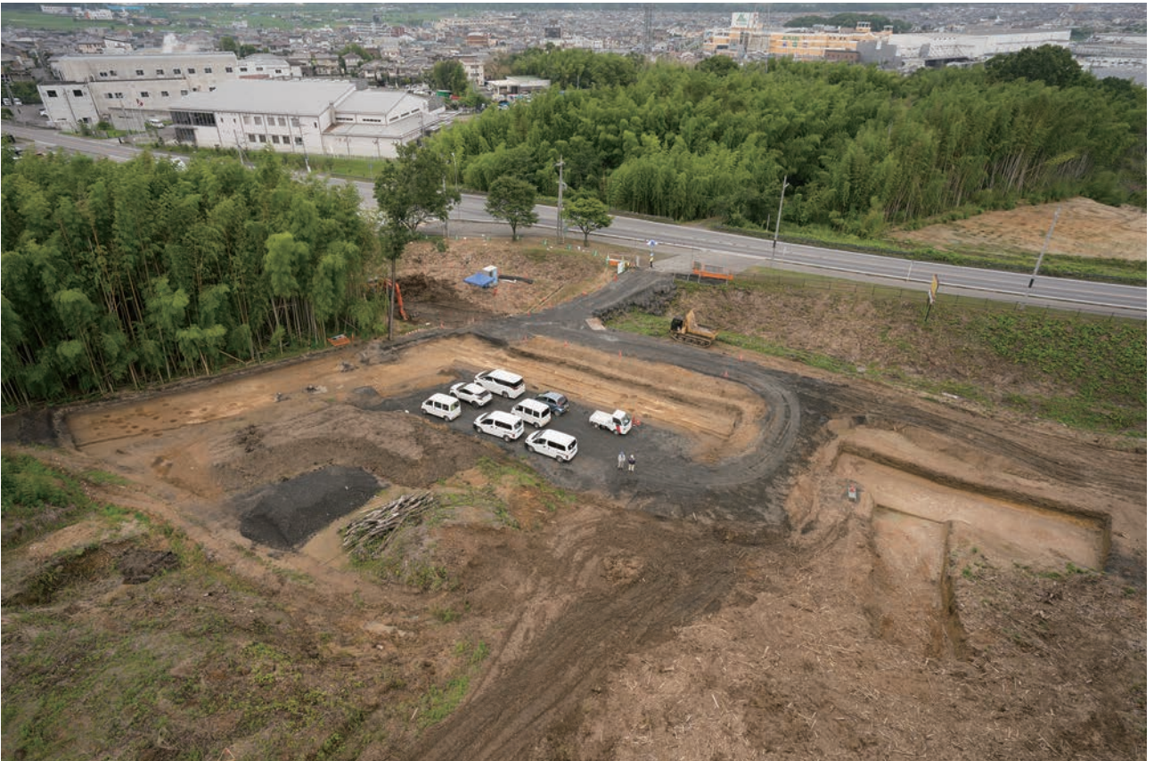
(2) Q地区遠景(北東から)
