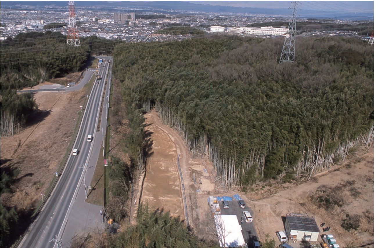
(2) I地区全景(南から)
