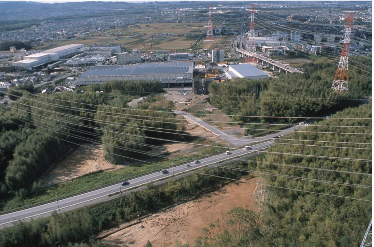
(1) M-1地区遠景(南東から)
