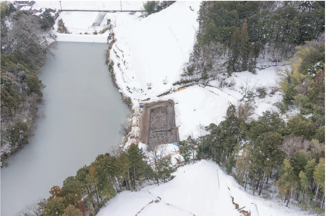
(2) 調査地遠景(北から)
