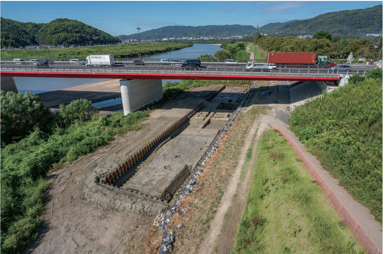
(2) 遺構面掘削状況(東から)
