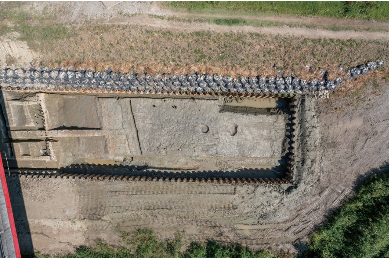
(2) 遺構面東側掘削状況(上が北)
