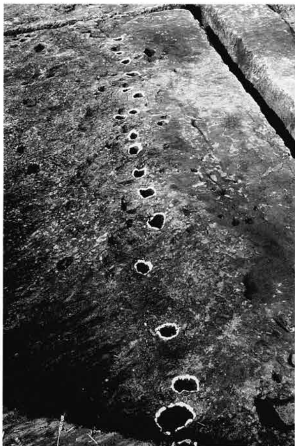
杭穴列（南縁辺部）
