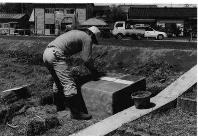
5. 成塚石橋遺跡説明板設置状況
