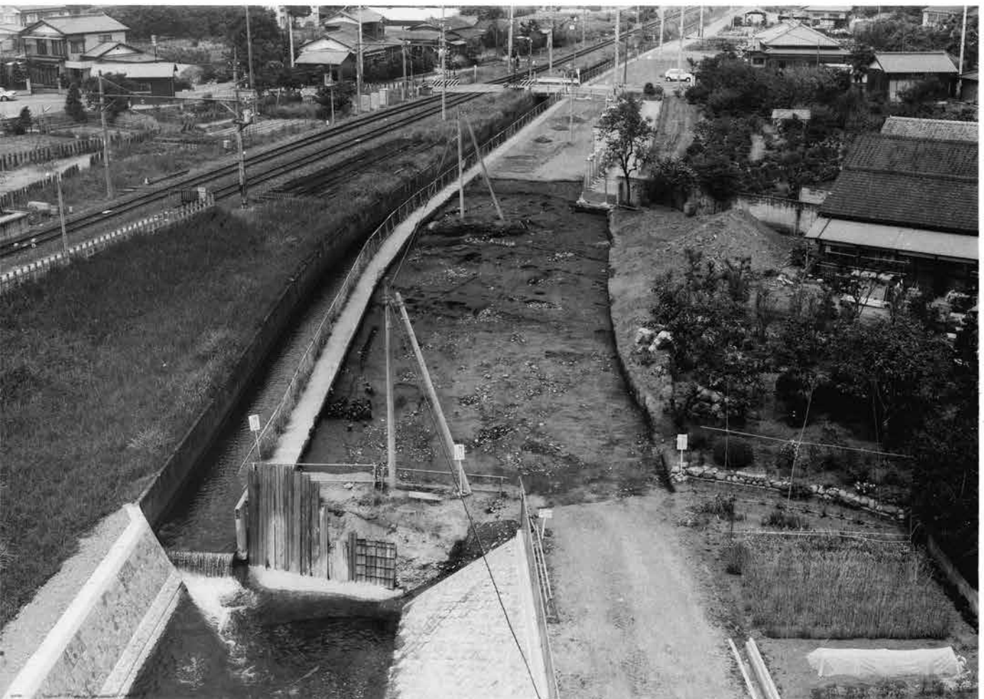
2. 4区南半全景 南東から
