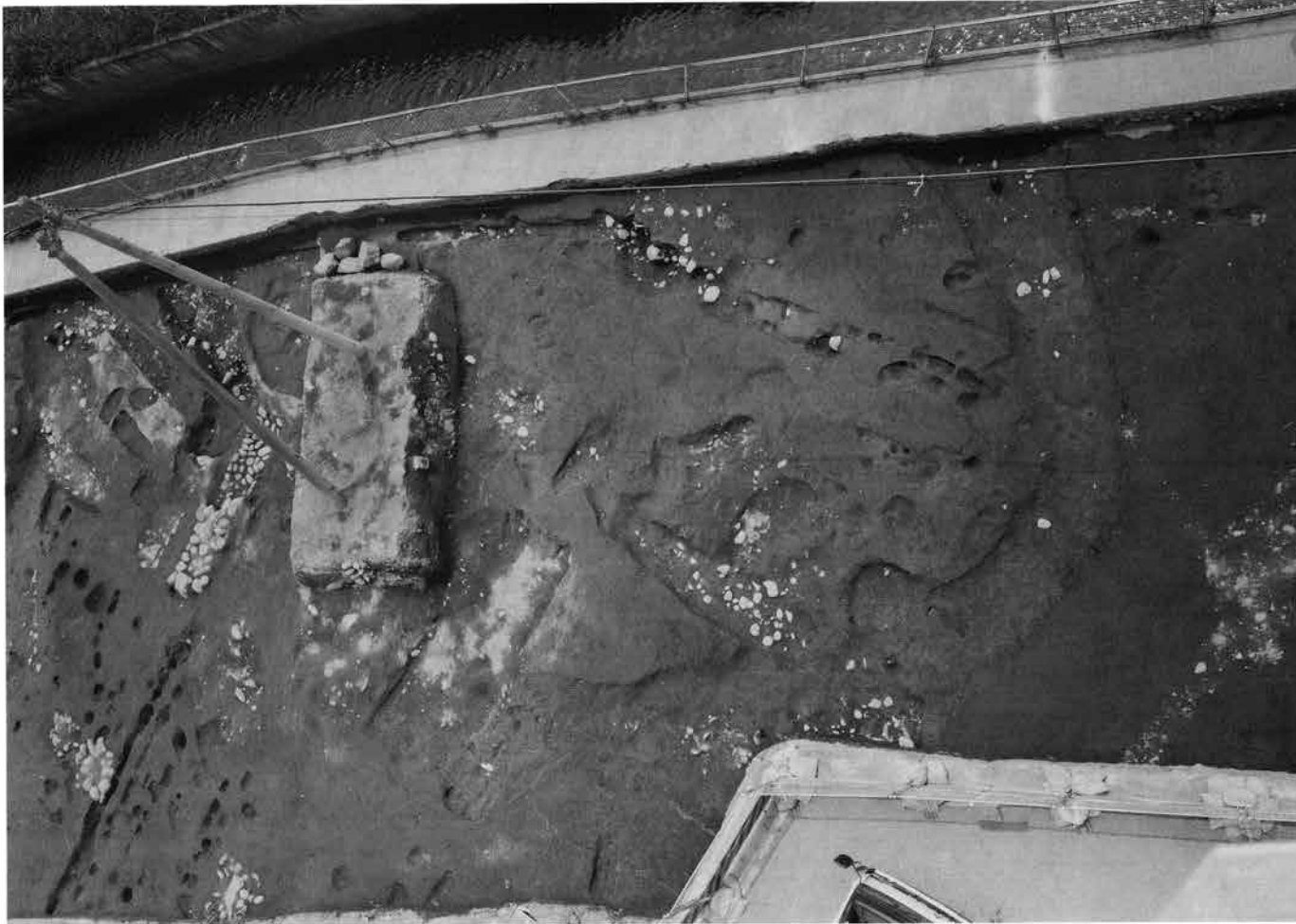
1. 9号石垣全景 北東から
