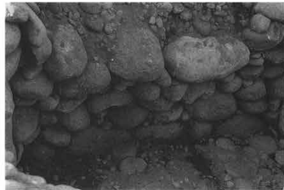
的場D号墳玄室左壁石積状況 東→
