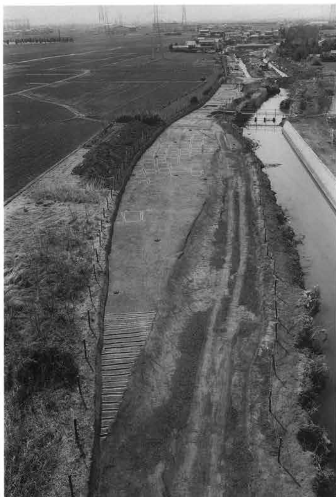
2.Hr-FA下水田全景(北から)
