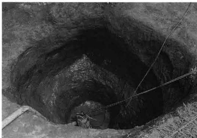
2. 30号井戸全景(南西から)
