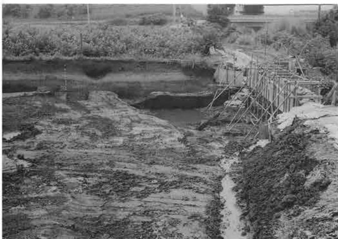
4. 第Ⅲ河道と善勝寺堀仮水路(北から)
