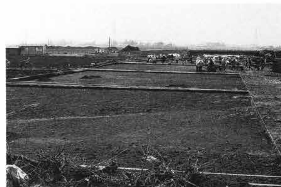
調査地南半を望む 北→
