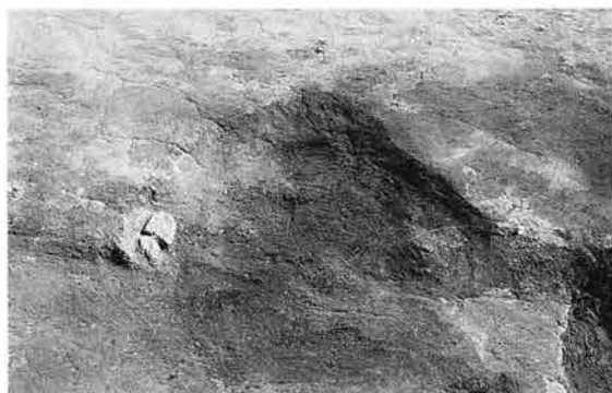
1. C区 36号住 カマド掘り方
