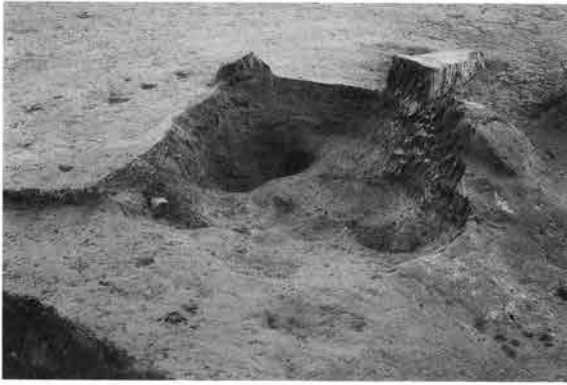
1 C区106号住カマド掘り方
