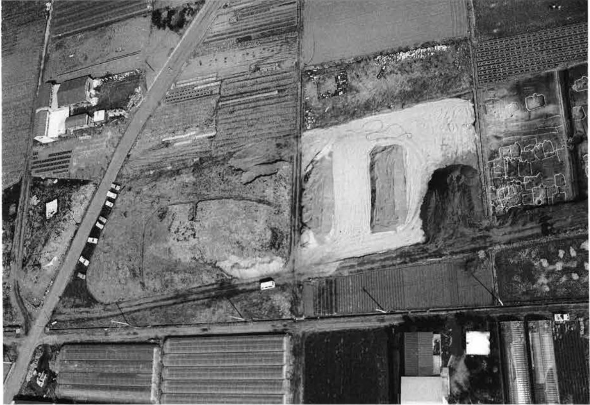
1 橋脚部埋め戻し状況
