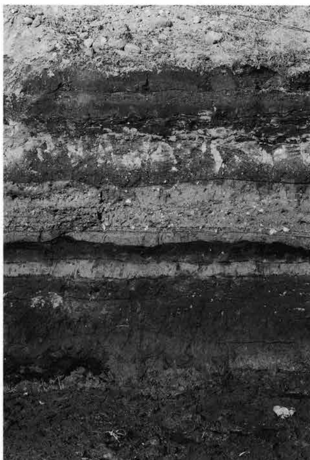
北カルバート部北壁 50-H09
