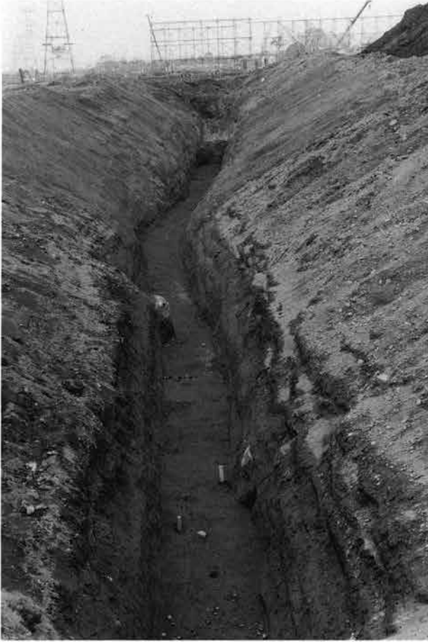
南区域外東側トレンチ
