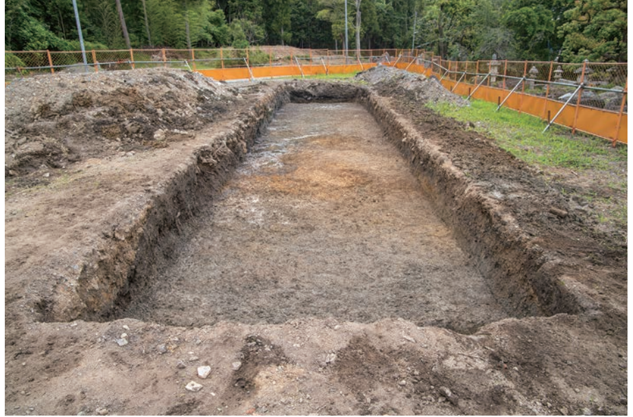
(1) 1 トレンチ全景(東から)
