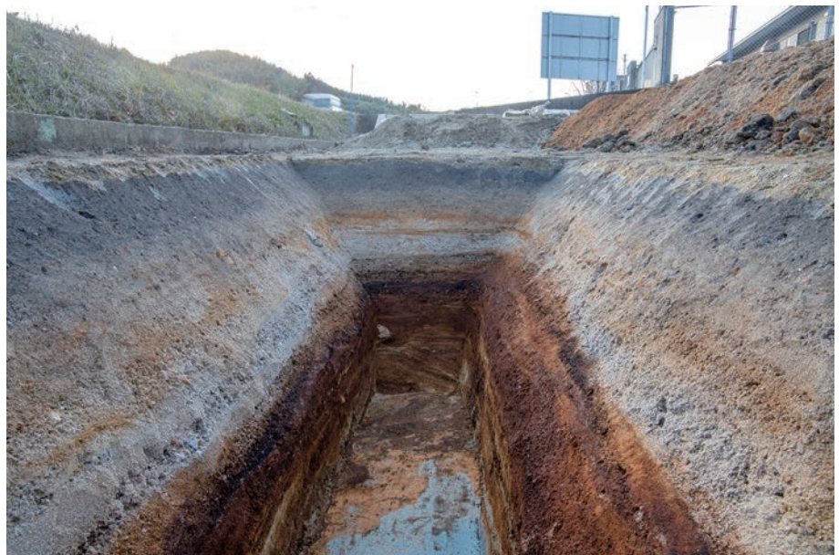
(3) 9 トレンチ西壁(東から)
