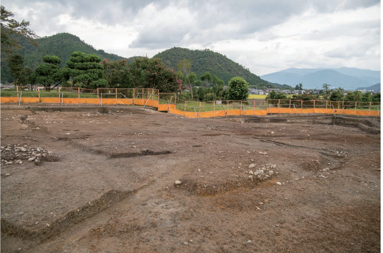
(1) 区画溝 S D01 全景 (南西から)
