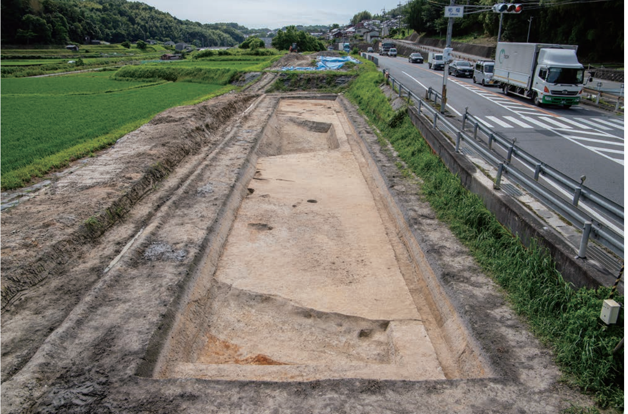
(1) 2 区地山面全景(東から)
