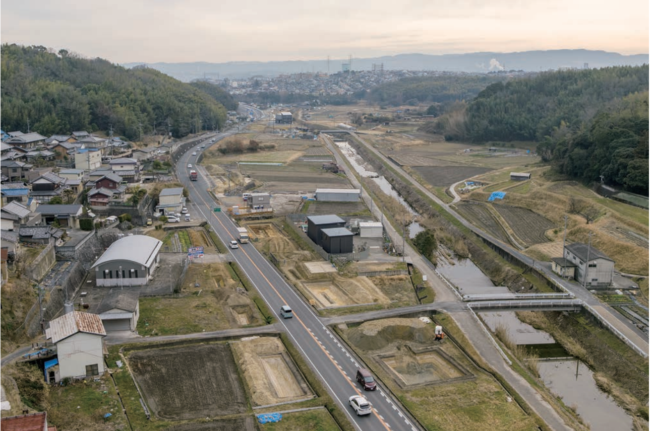
(1) 調査区遠景(北東から)
