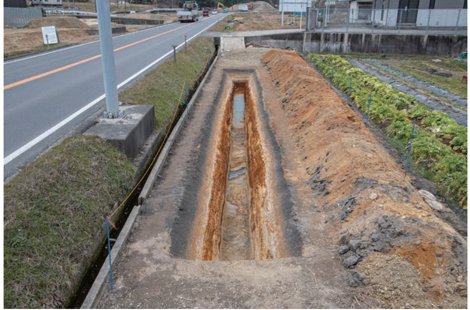
(1) 9 トレンチ全景(東から)
