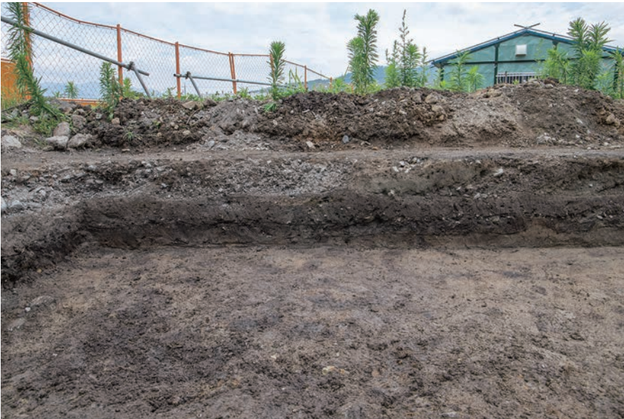
(2) 5 トレンチ断面(南西から)
