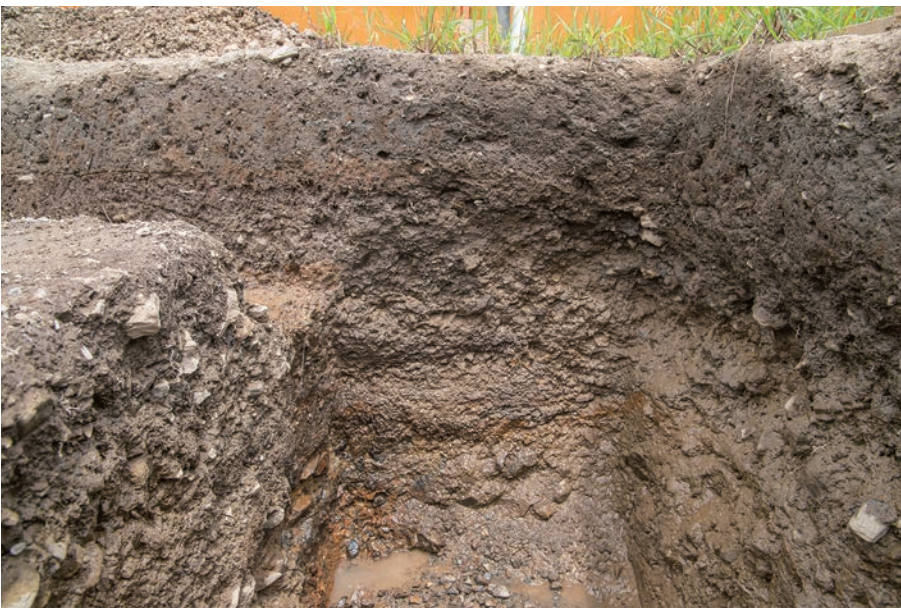
(3) 2 トレンチ断ち割り断面 (南から)
