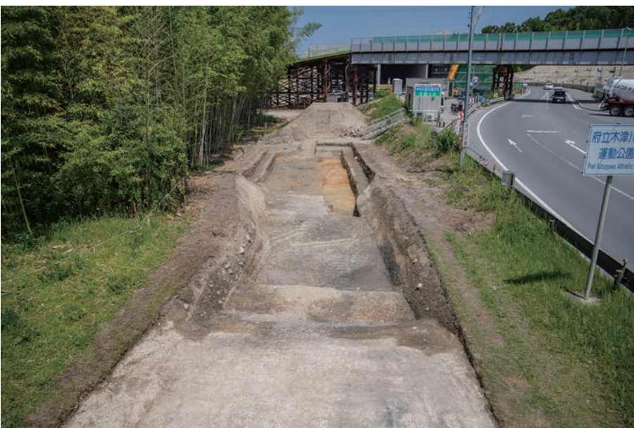
(3) X-2区調査トレンチ全景 (南から)
