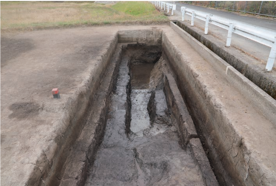
(2) NR 5 全景(南から)
