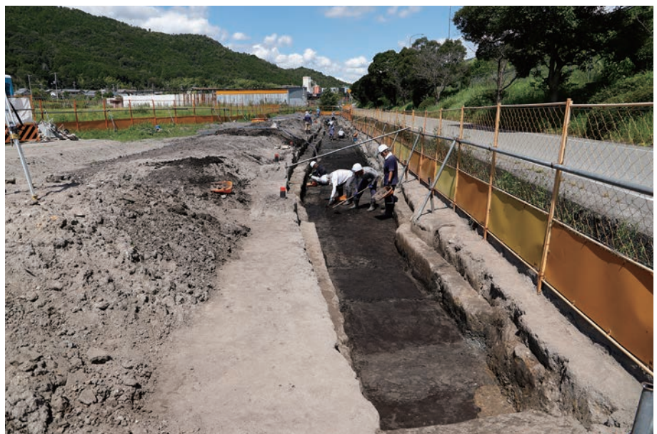
(3) 遺構検出作業状況(南東から)
