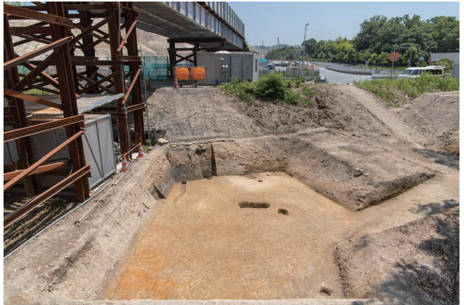
(2) X-1区調査トレンチ全景 (西から)
