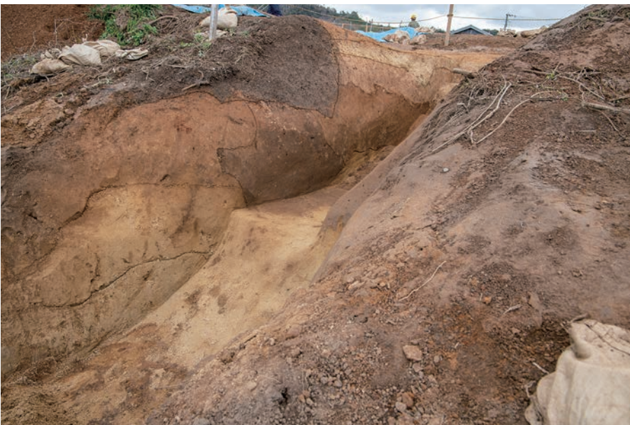
(3)斜面部堆積状況2(西から)
