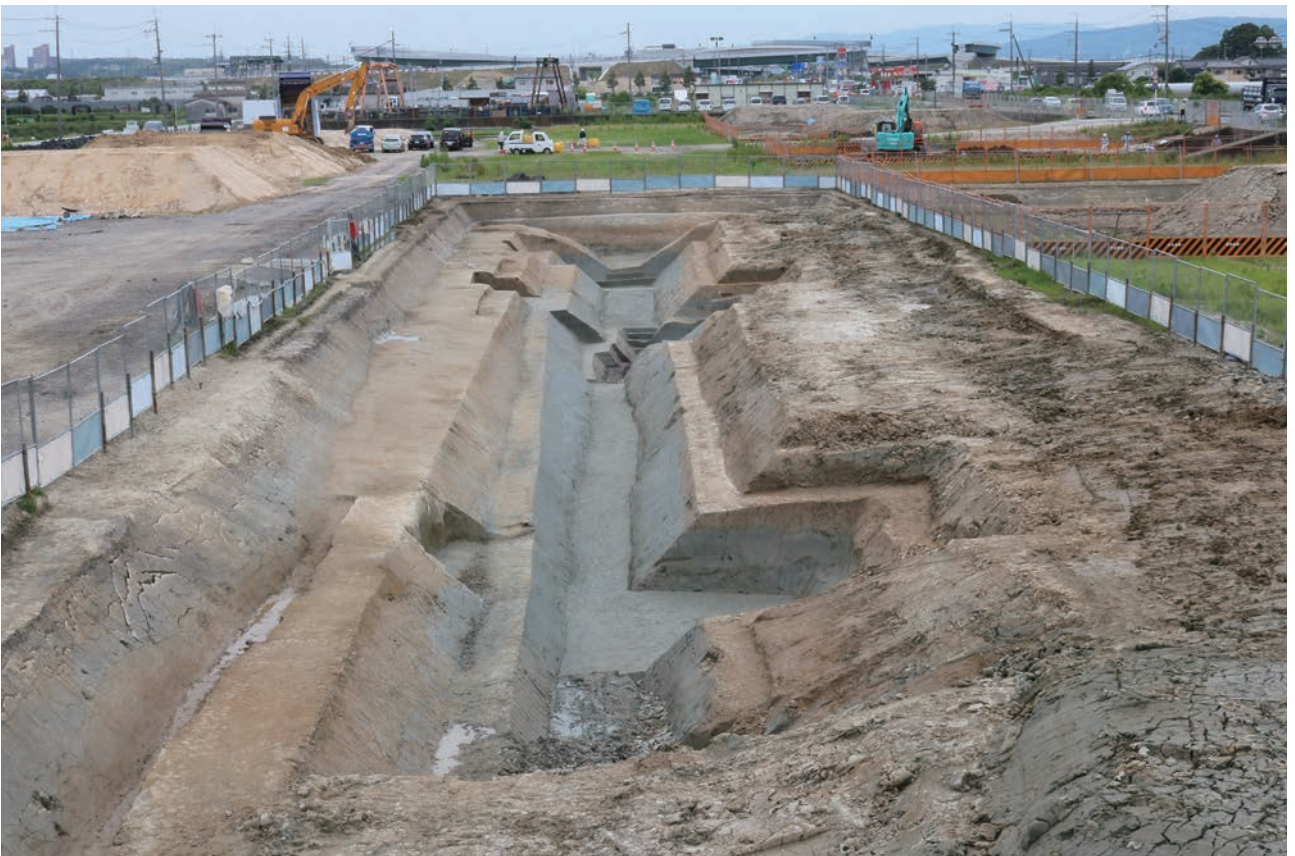
(2) G13区下層全景(東から)
