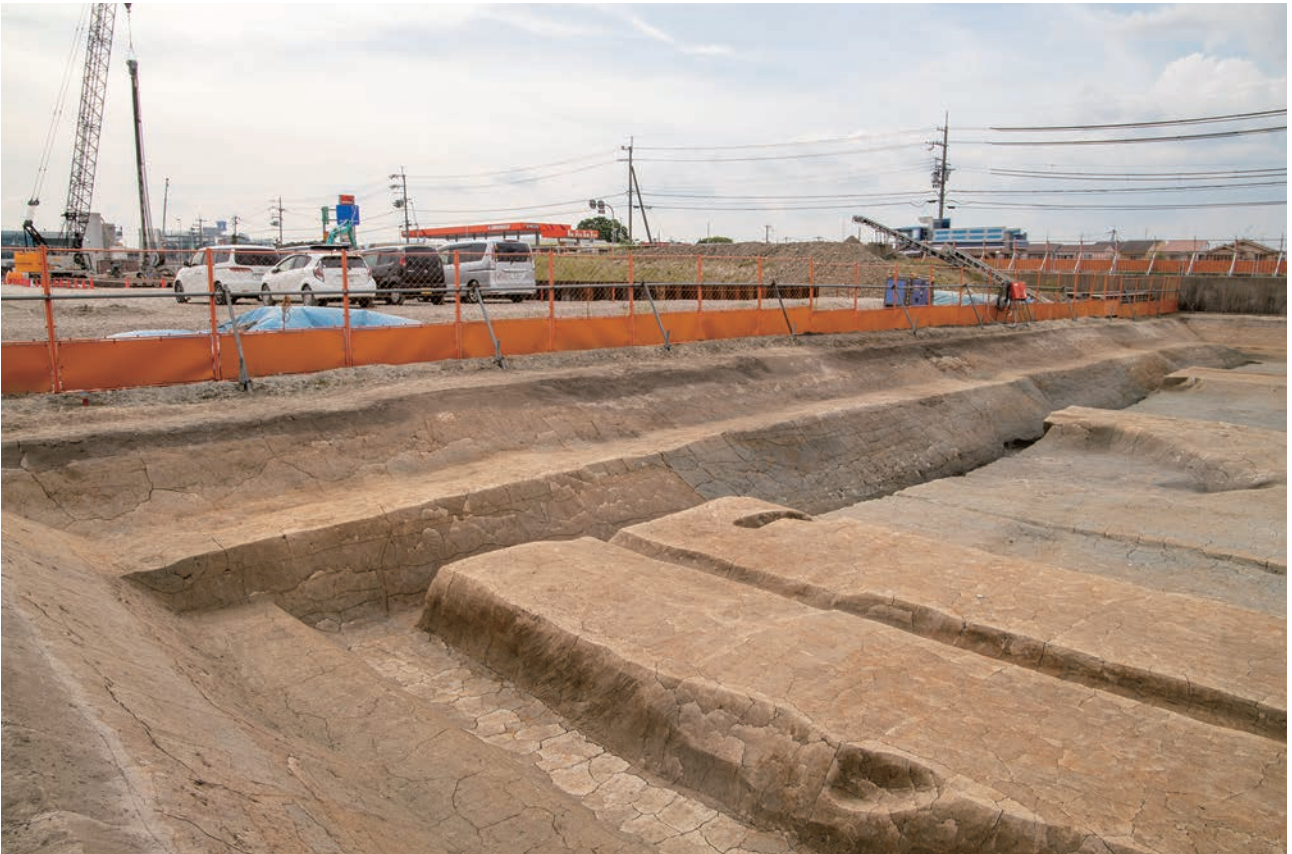
(2) F 5 区西壁土層断面(南東から)
