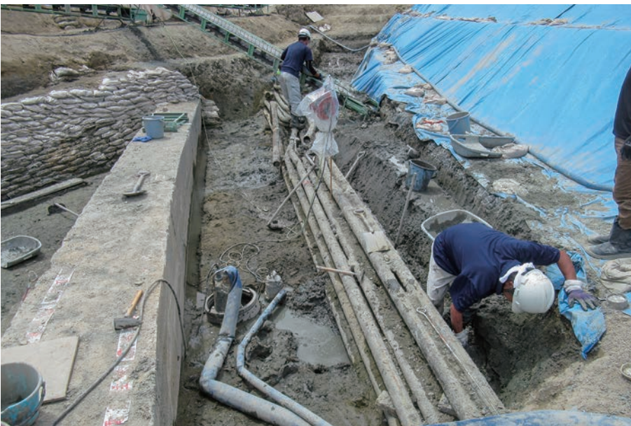
(3) E 8 区関西電力・NTT埋設管 検出状況(西から)
