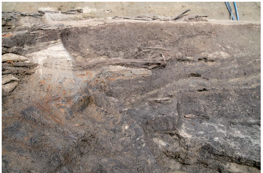
(3) F 5 区流路N R07土層断面 (西から)
