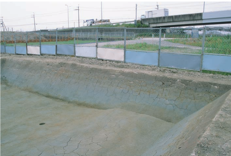
(3) G13区土層断面 (南東から)
