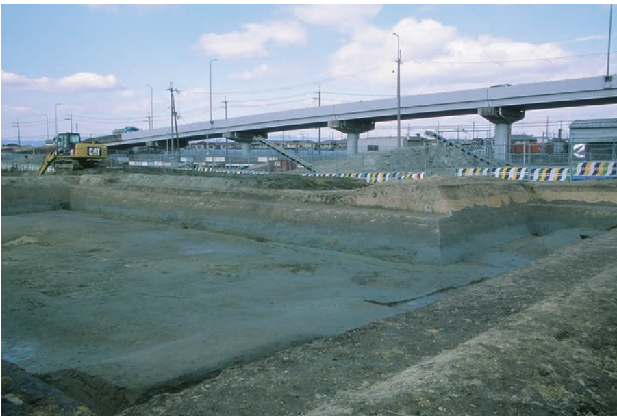
(3) G11区土層断面(北東から)
