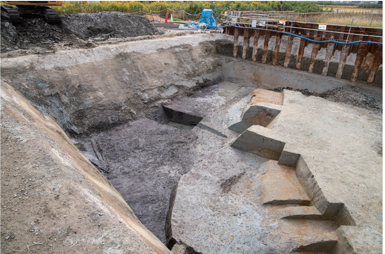
(2) G15区下層流路NR01(北西から)
