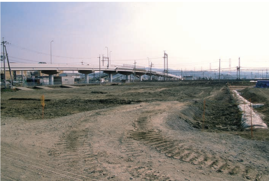
(3) G11区調査終了後状況 (南西から)
