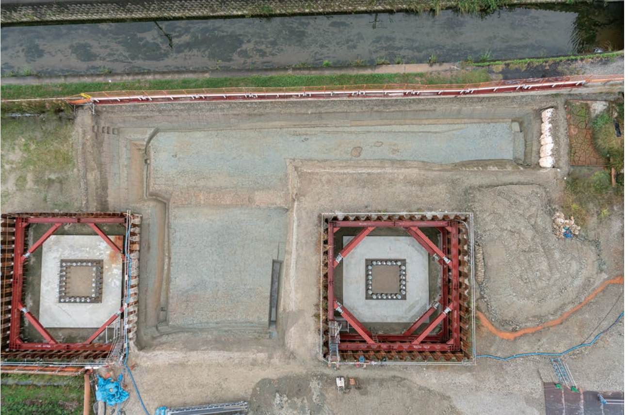
(1) G15区全景(上が西)
