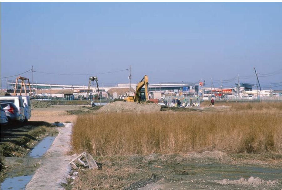
(3) G12区埋め戻し作業 (南東から)
