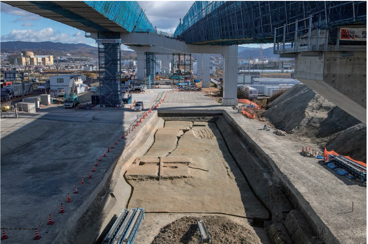
(2) F 8 a 区全景(西から)
