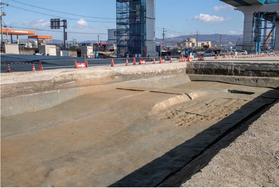
(1) F 8 a 区島畑128・ 溝群 S D03 検出状況 (南西から)
