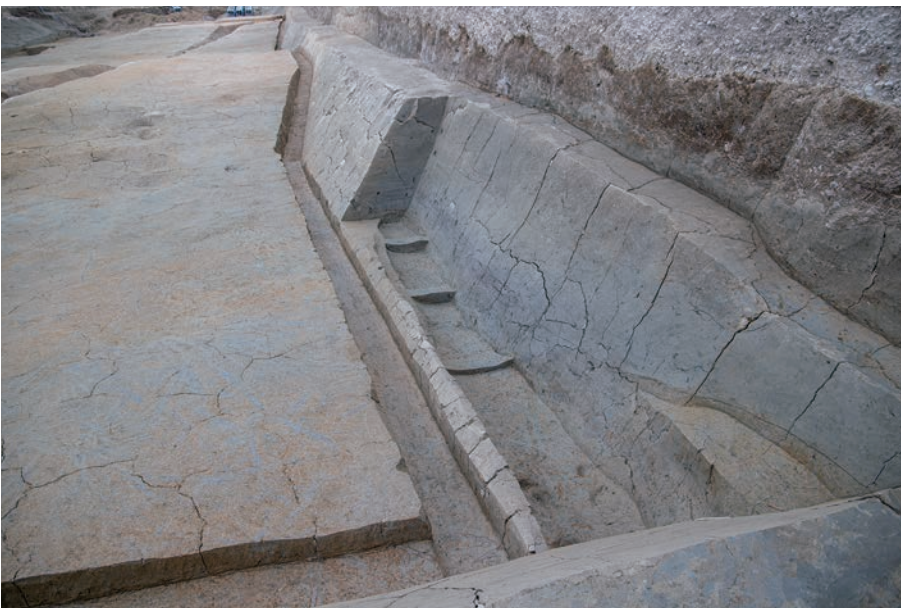
(3) F 8 a 区氾濫流路 NR11検出状況(東から)
