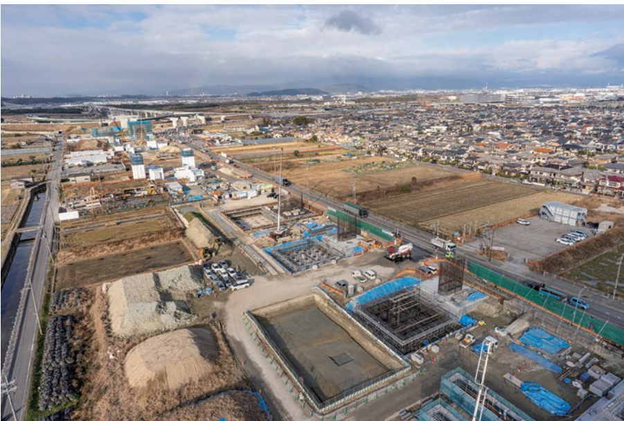
(3) G16区西半遠景(南東から)
