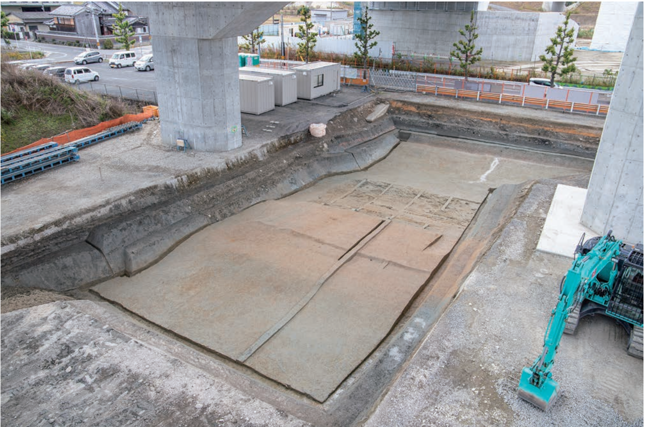
(2) F 7 区全景(北東から)
