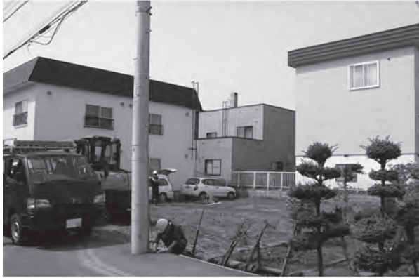
A 事業地近景(北東から)
