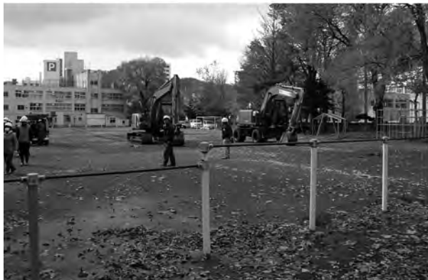
A 事業地近景(北東から)
