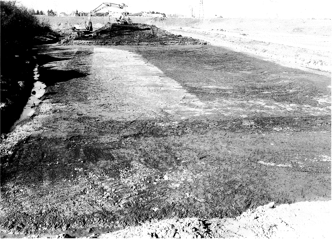
E区表土掘削状况
