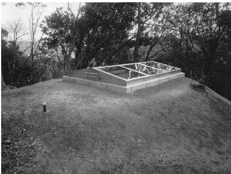
石室保存公開施設完成
