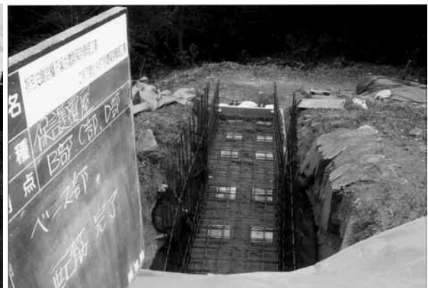
保護覆屋ベース鉄筋組立
