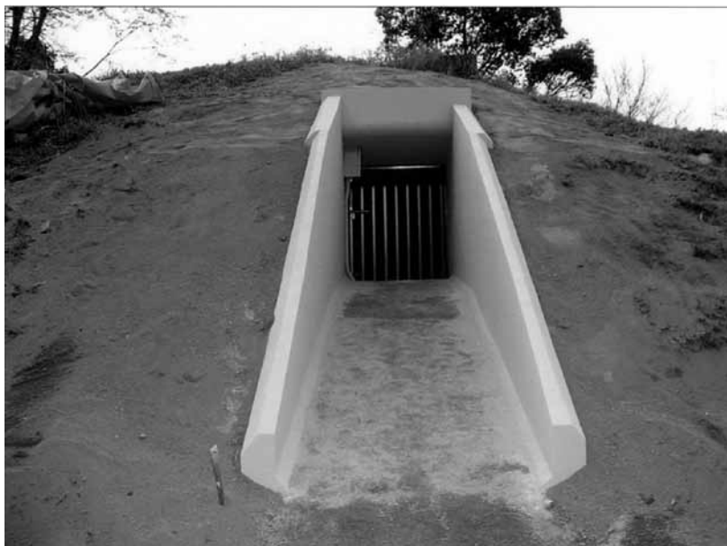
本体工事完了状況
