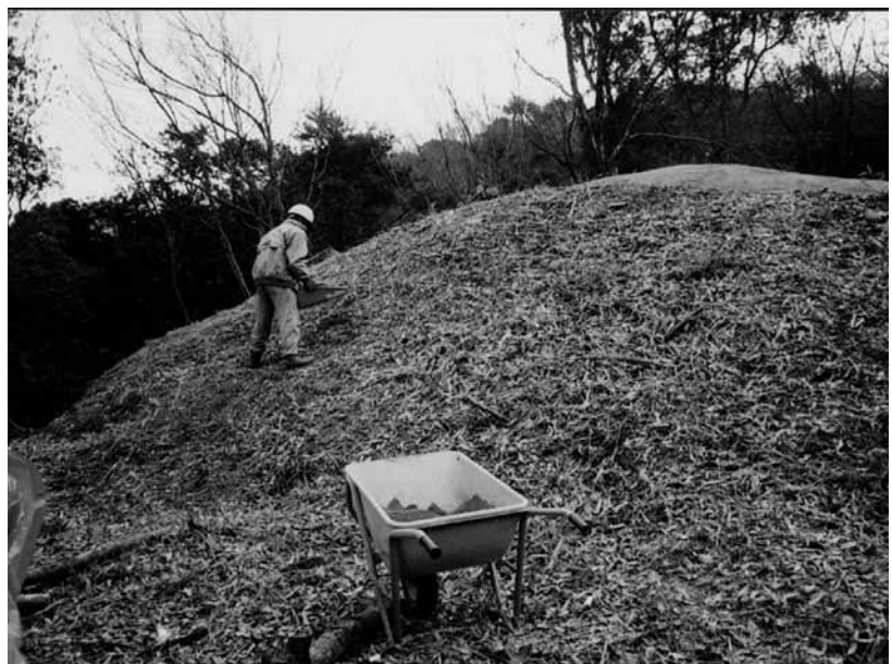
真砂土の人力運搬と墳丘盛土
