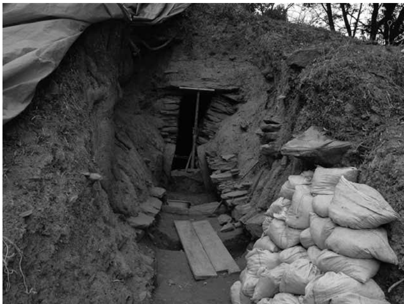
羨門排水溝追加調査（南から）
