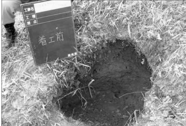
盗掘坑埋め戻し前
