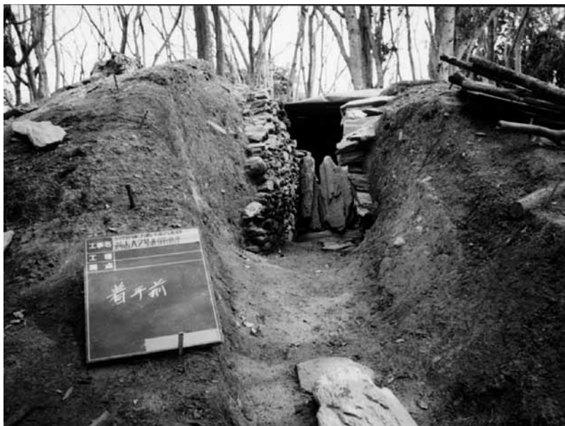
整備工事着手前状況
