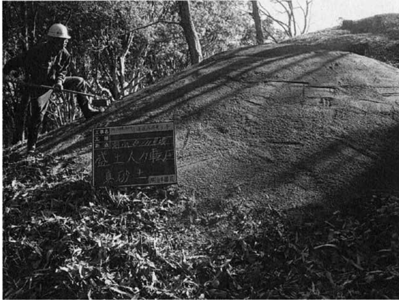
墳丘盛土の人力顛圧
