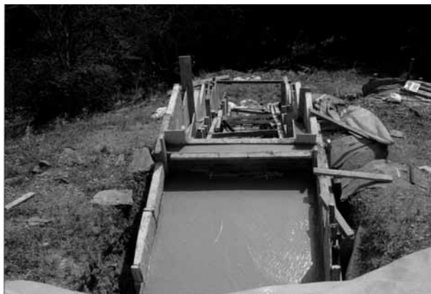
石室入口保護施設天井部コンクリート打設
