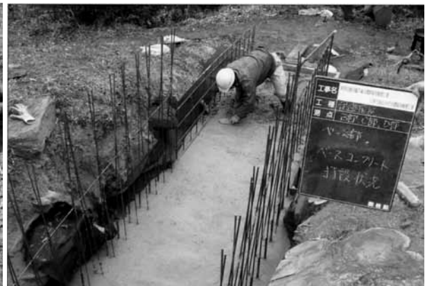
ベースコンクリート打設状況
