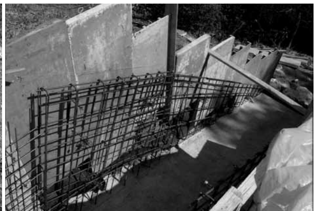
保護覆屋側面鉄筋組立
