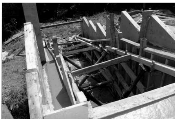
石室入口保護施設側面コンクリート打設
