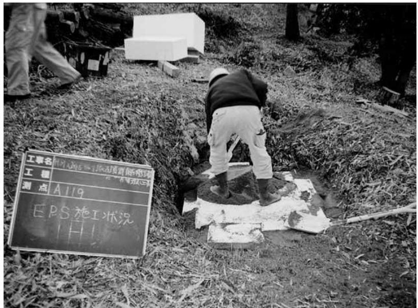
石室内 EPS 使用状況 (前山 A 119 号墳)
