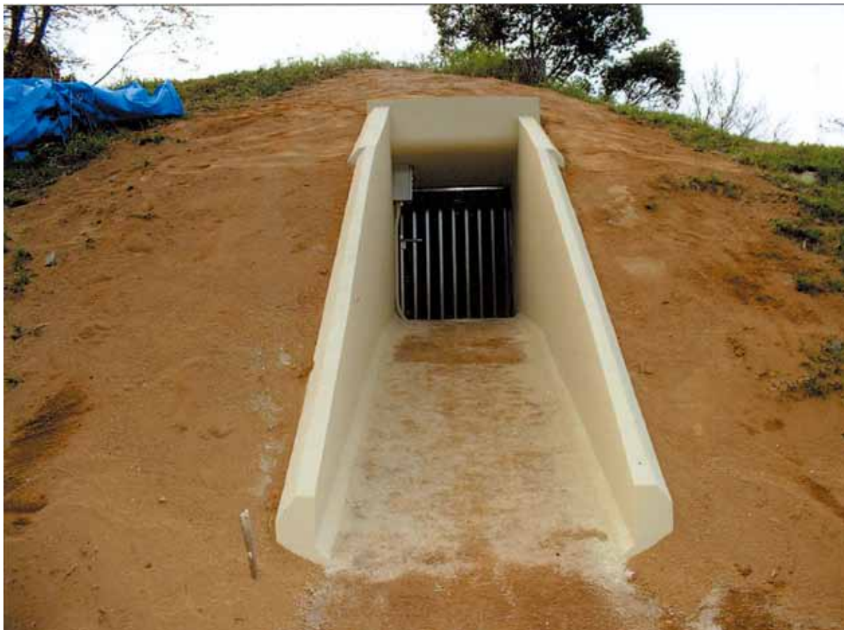
前山A 67号墳 石室保存公開施設 (南から)
