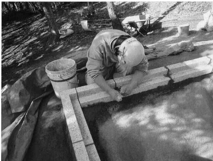
花崗岩基礎据え付け状況
