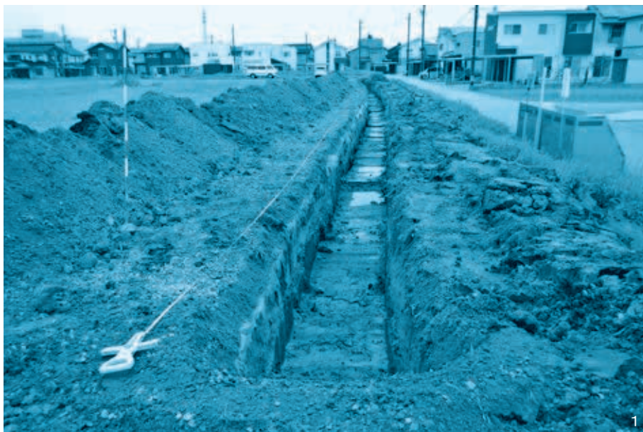
1. 3T全景 (南から)
