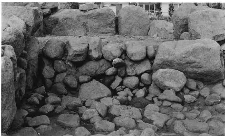
閉塞石の状態
