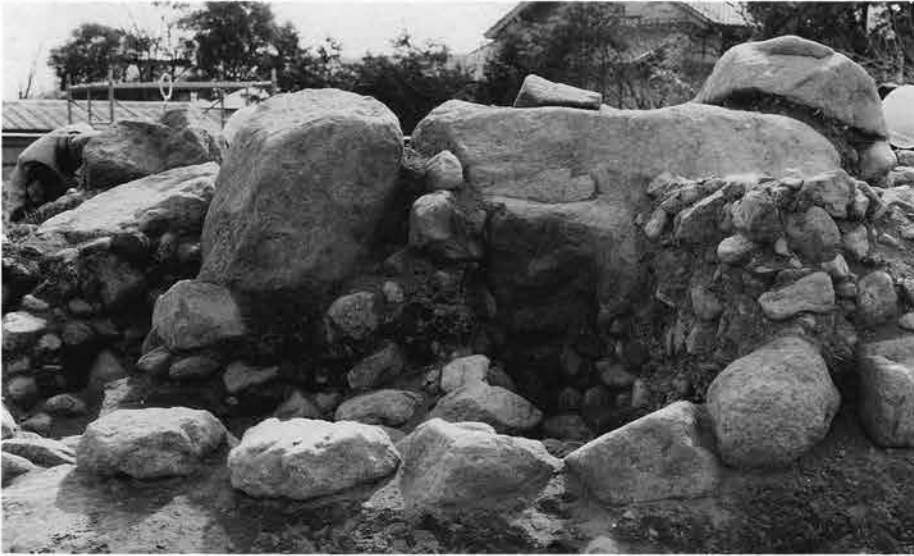
裏込め石の状態
