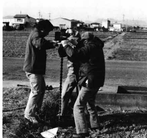
簡易ボーリング調査スナップ
