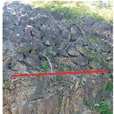
e 東崖面3地点拡大写真(朱線:岩盤面)
