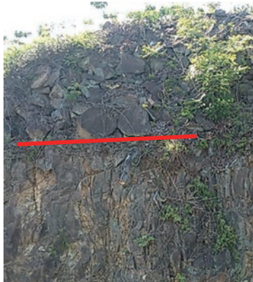
c 東崖面1地点拡大写真(朱線:岩盤面)
