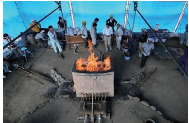
写真 11 佐夜ノ谷2遺跡の製鉄炉復元
