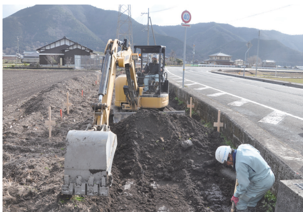
調査風景（機械掘削）
