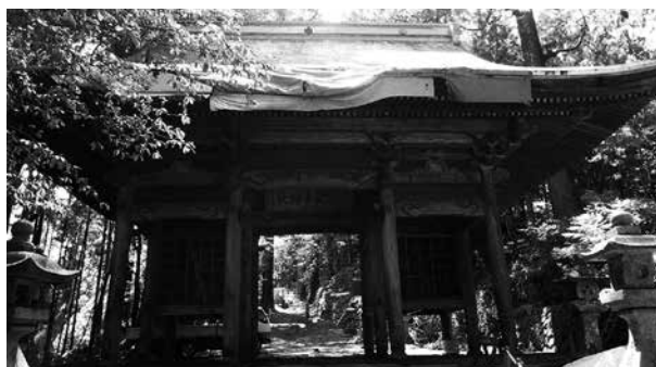
修理前 正面(東面)
