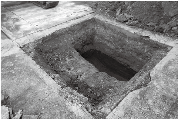
調査坑3完掘状況
