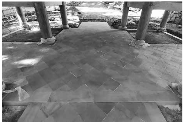
四半敷石張り
