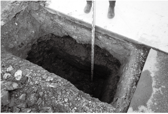
調査坑4完掘状況
