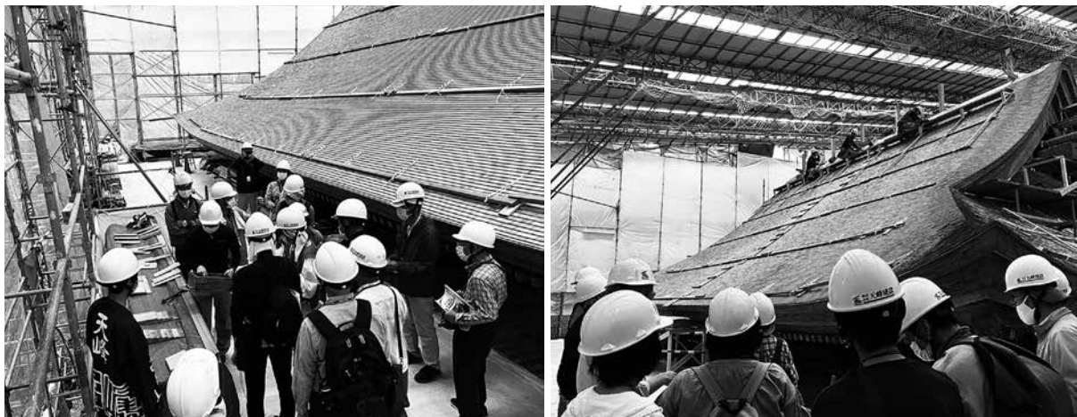
修理工事見学会
