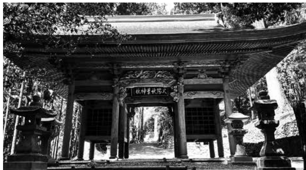
竣工 正面(東面)
