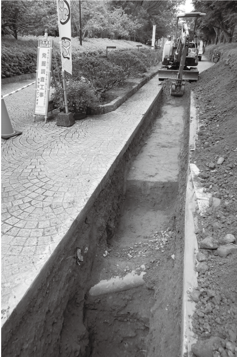
調査溝 1 本丸北側斜面検出状況
