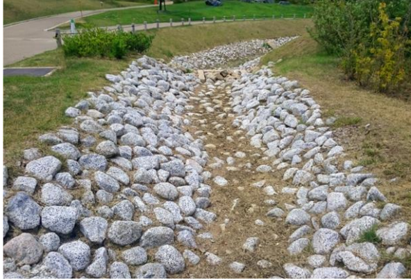
図 47 石張護岸ネット施工例 (国営飛鳥歴史公園 キトラ古墳周辺地区)
