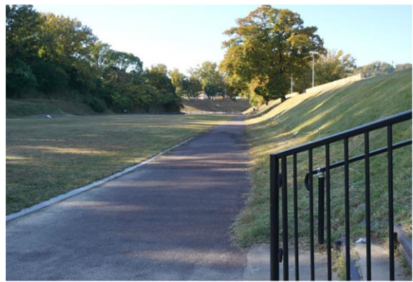
図 41 周濠内の緊急車両用通路の例(今城塚古墳)
