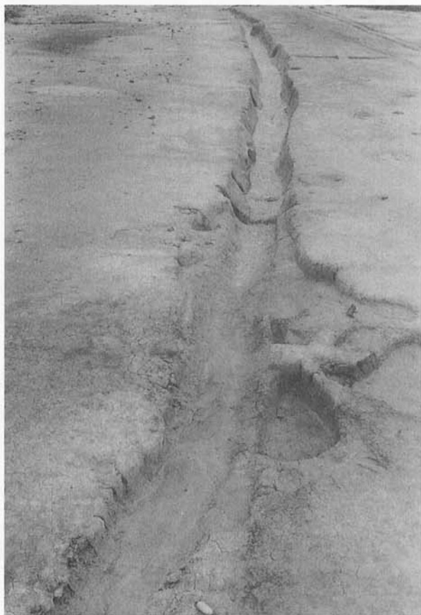
2 地区SD01 全景 (東から)
