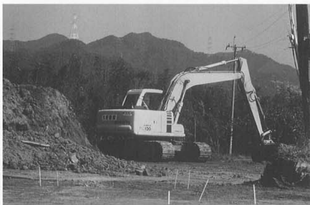
重機による表土除去
