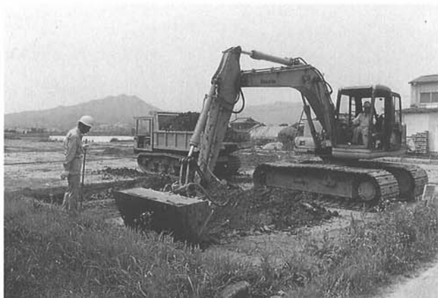
重機による表土除去
