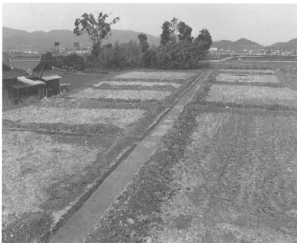
トレンチ設定状況（東より）
